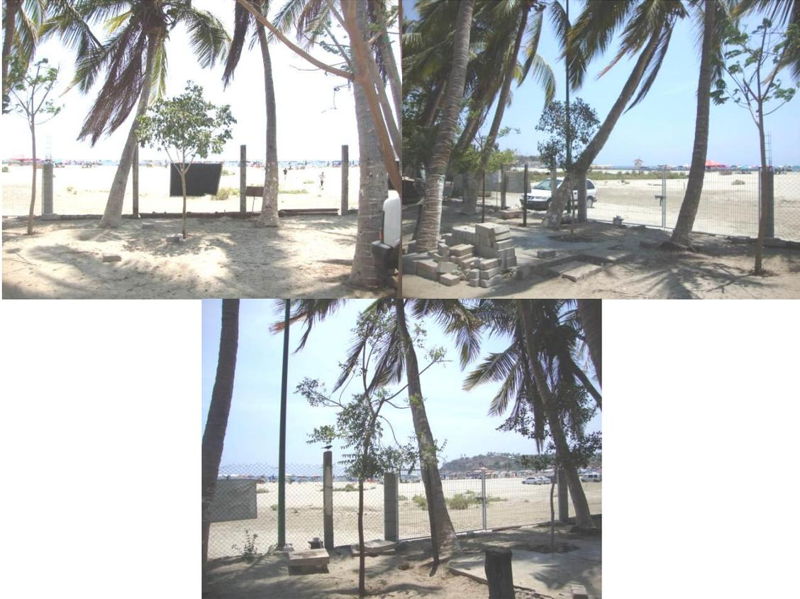
Figura II. 4 a la 6. Cerca perimetral con postes de concreto y malla ciclónica.
