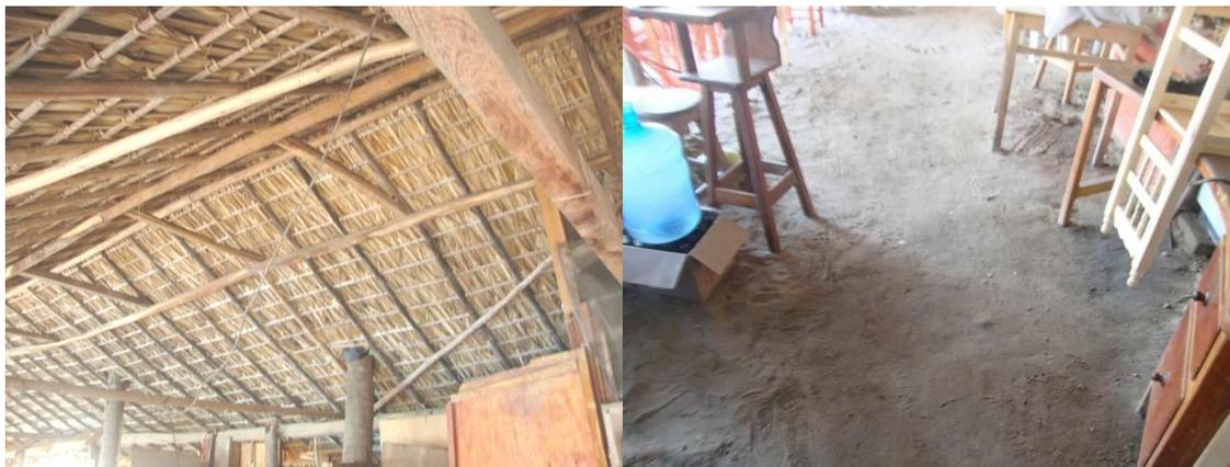
Figura II. 15 y 16. Techo tipo palapa y piso natural del restaurante.
