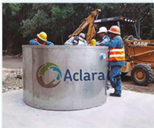
**Fig. 63.-** Se muestra una foto de la planta de tratamiento de aguas residuales de forma circular o cilíndrica Aclarapack.
