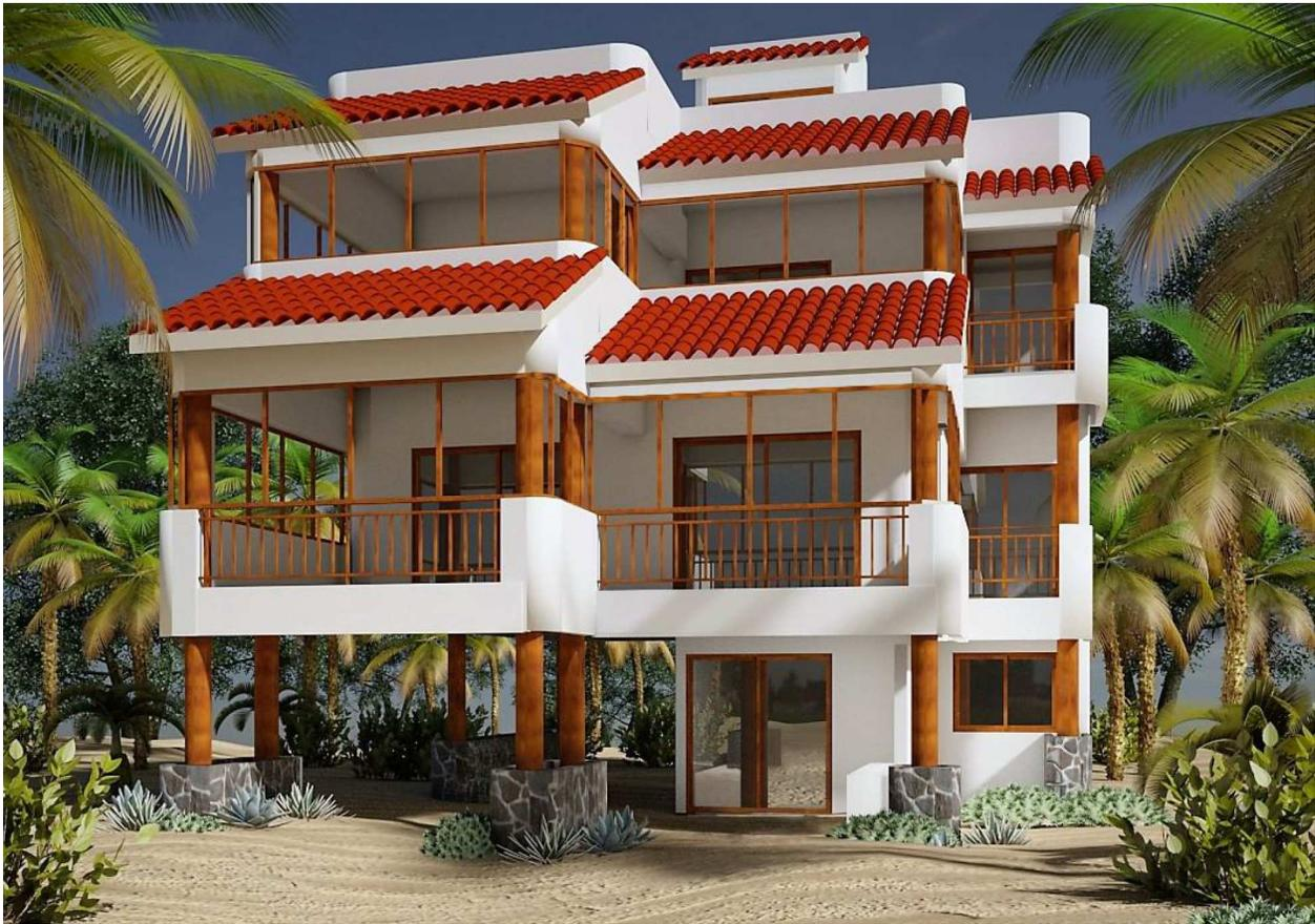
**Figura 12.-** Perspectiva (modelo computarizado) de la villa propuesta en el proyecto, en esta imagen se observan claramente los niveles que integran el proyecto: planta baja y primer, así como el piloteado para estar por encima del nivel medio del mar a cuando menos 2.5 metros.
