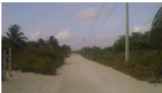
Foto IV.3. Camino costero en el extremo poniente del predio
