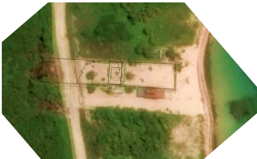
Figura II.17. Área de construcción de la Casa de Veraneo (Retiros), con respecto de la vegetación.
