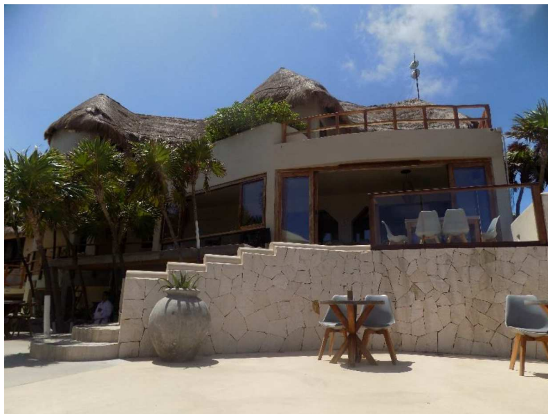
Figura VIII. 2 Fachada del interior del Hotel
