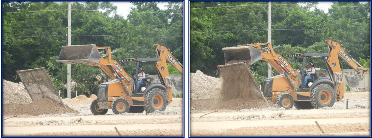
Figura 29. Cribado de tierra rescatada, según experiencias previas en campo.
