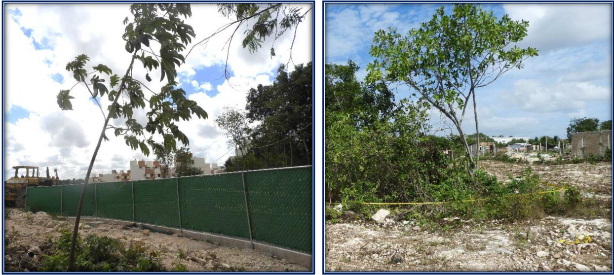
Figura 34. Malla y cinta delimitadora instalada en obra, según experiencias previas en campo.
