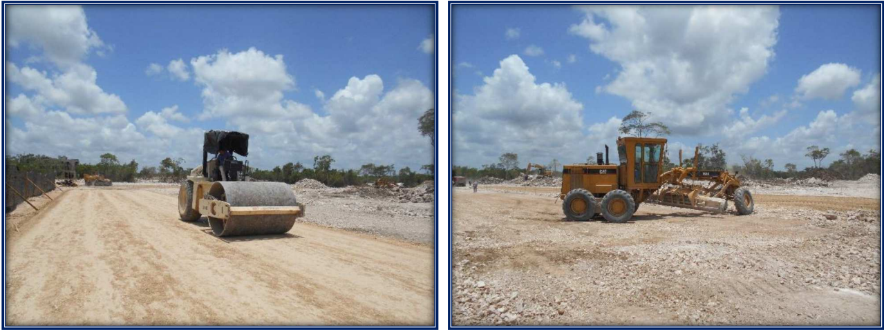
Figura 3. Terraplenes en obra, según experiencias previas en campo.
