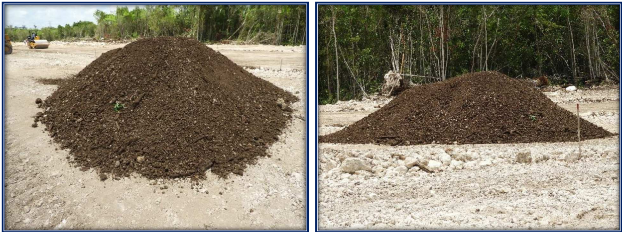
Figura 28. Almacenamiento de tierra rescatada, según experiencias previas en campo.
