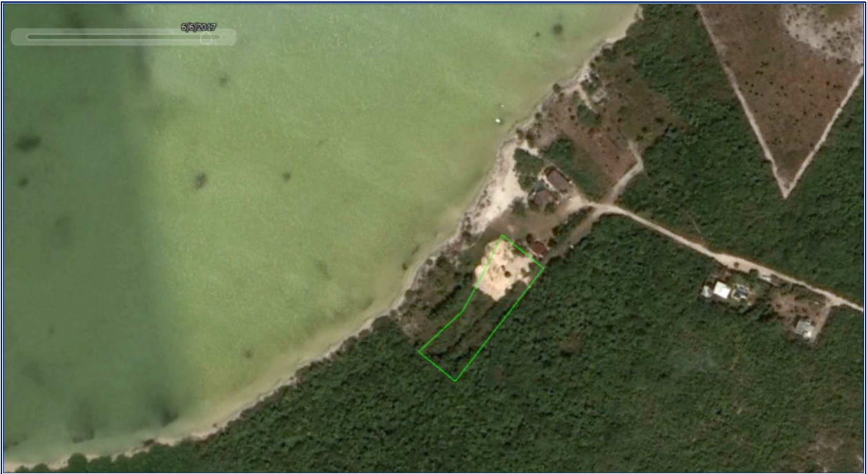
Figura 13. Afectaciones originadas al predio en los años 2016 y 2017, producto de la invasión a la que estuvo sujeto.
