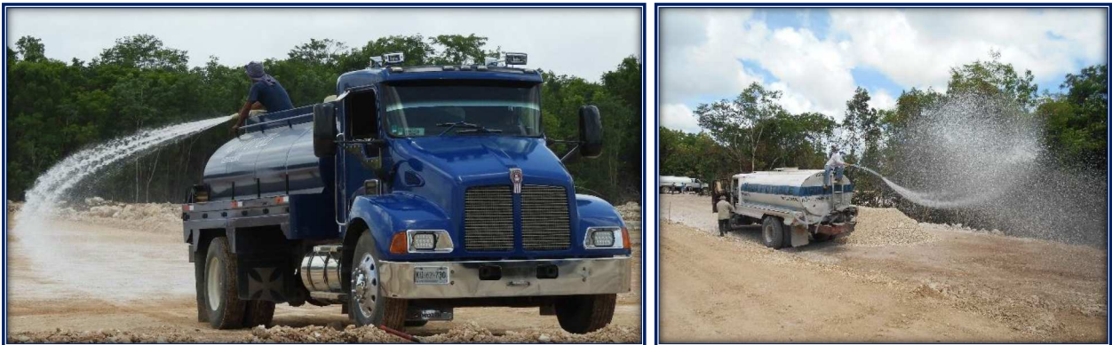
Figura 31. Humedecimiento de las áreas de aprovechamiento, según experiencias previas en campo.
