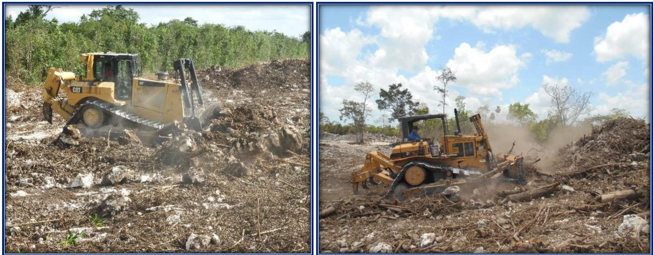
Figura 2. Actividades de despalme, según experiencias previas en campo.
