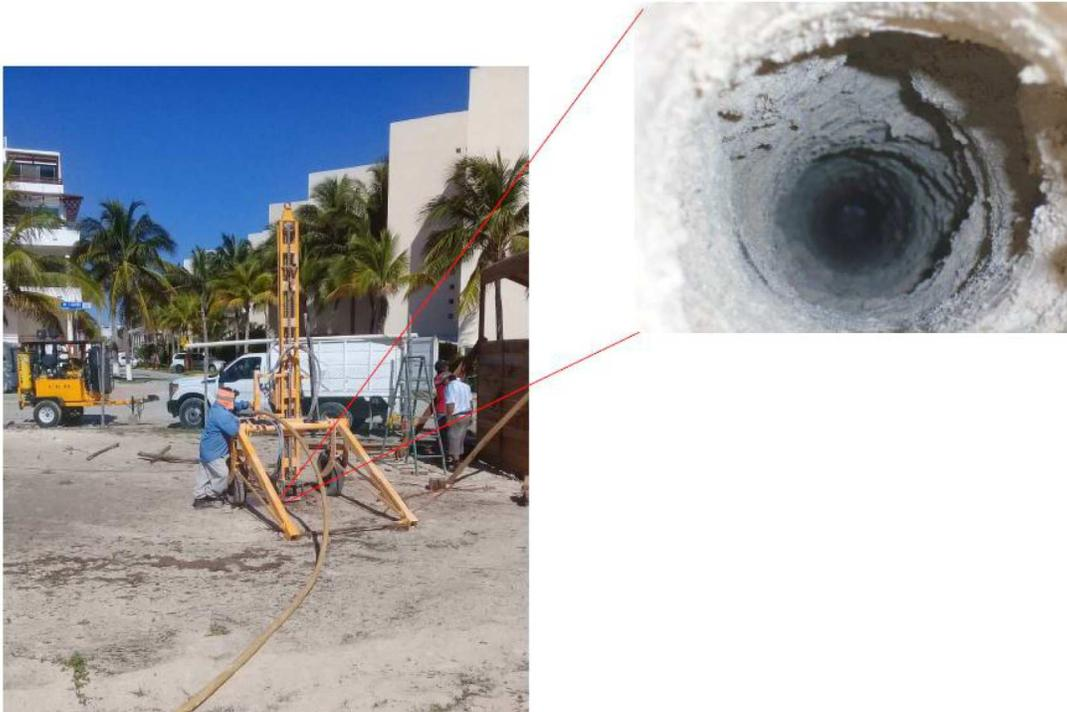
**Figura 2.11.** Trabajos de exploración geotécnica (Estudio de Mecánica de Suelos).
