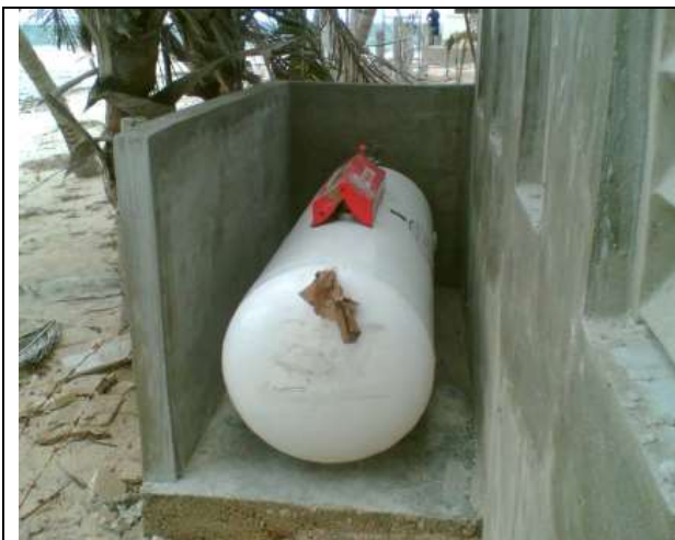
Ejemplo de tanque estacionario de Gas.
