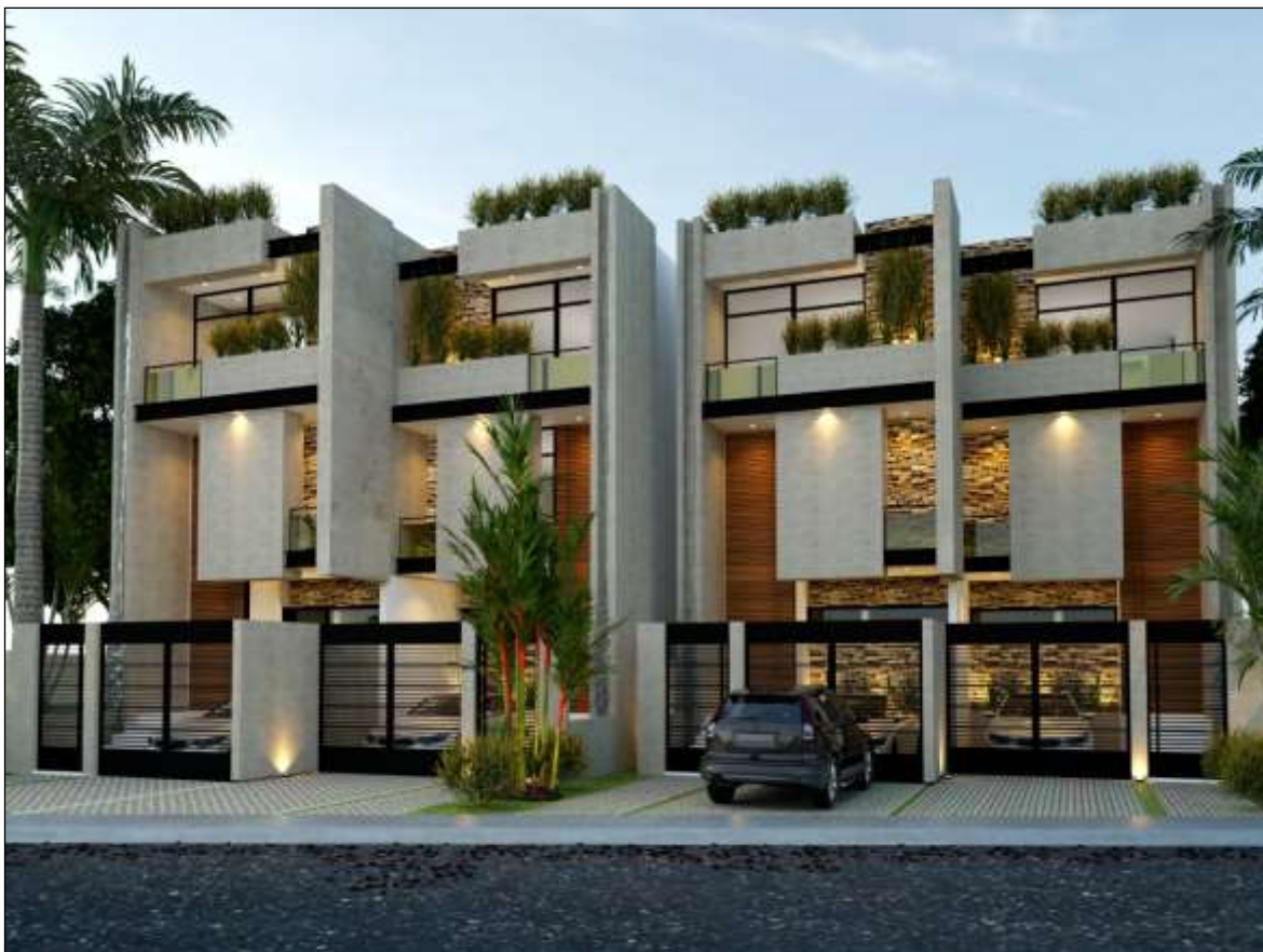
Perspectiva del proyecto. Se observa el frente del proyecto.
