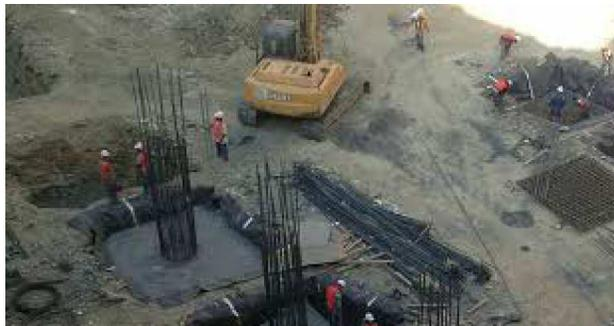
Figura 61 Ejemplificación de la medida de mitigación para aislar la construcción de la cimentación con el suelo y el manto freático
