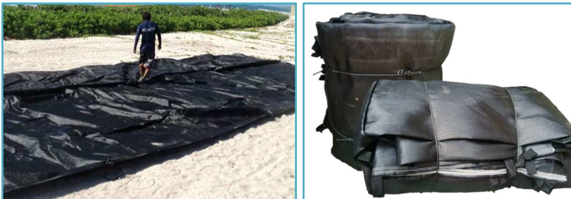
Figura II_ 17. Tubos de geotextil para el desplante de la estructura ciega del muelle.
