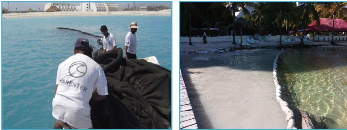
Figura II_ 11. Colocación y funcionamiento de malla antidispersión en proyectos similares.
