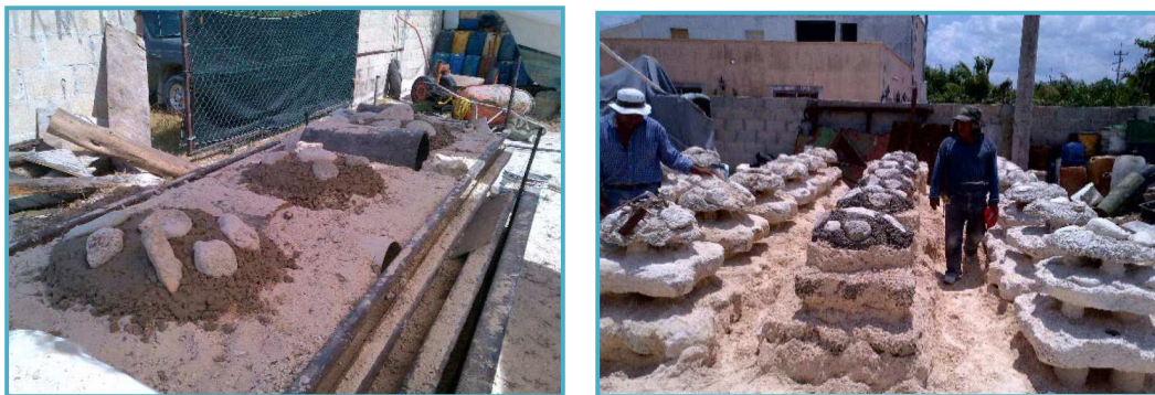
Figura II_ 26. Fabricación de arrecifes en el patio de colado.
