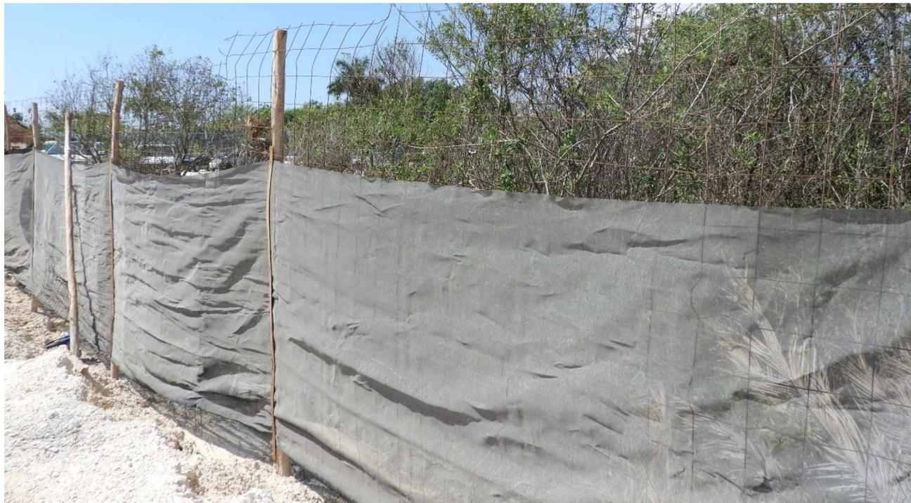
**Figura 7 .** Malla instalada para la reducción de polvo fuera de las áreas de trabajo.
