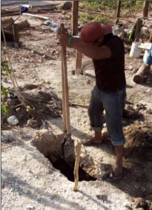
La excavación se realizará por medios manuales (pico y pala). Para la construcción de las zapatas se realizaran excavaciones de 50 cm de profundidad como máximo, dependiendo de la profundidad que se encuentre la piedra laja.
