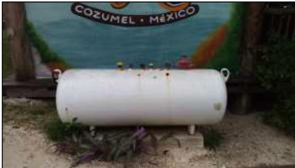
Básicamente se utilizará como combustible solo el gas butano de uso doméstico, que servirá para el funcionamiento de la cocina de restaurante. Se utilizará un tanque estacionario de 1,100 litros de capacidad, mismo que será abastecido periódicamente por la empresa Z Gas.
