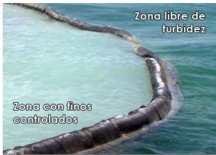
FIGURA 3. EJEMPLO DEL FUNCIONAMIENTO DE LA MALLA ANTIDISPERSIÓN
