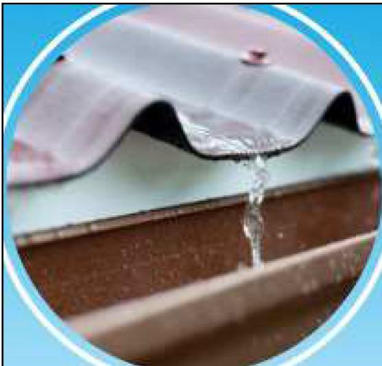
La presente imagen muestra el escurrimiento del agua pluvial sobre las laminas a la canaleta.
