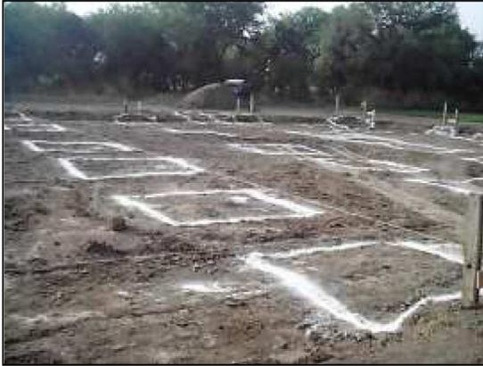
Una vez realizado el trazo, se marcará con cal el lugar exacto donde se realizara la excavación lineal para el alojamiento de la cimentación.
