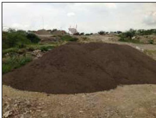
Durante el despalme del terreno, la tierra vegetal de la superficie del terreno desmontado será retirada y apilada cerca del área donde se encuentra el vivero. La tierra vegetal se mezclará con los residuos vegetales que fueron triturados, esto con el fin de enriquecer la tierra orgánica. Posteriormente el producto enriquecido será utilizado para las actividades de reforestación, para las macetas de las áreas jardinadas y para las áreas verdes naturales que se tienen
