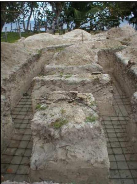
Una vez que se hallan trazado las áreas de desplante de las obras, se iniciará con la excavación de las zanjas de cimentación.
