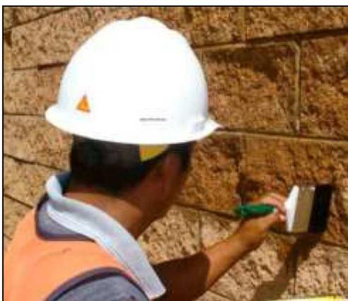
Existen dos **tipos de selladores**: los pigmentados y los transparentes. La función de ambos es la misma, salvo en la hora de la aplicación, en el que el sellador pigmentado termina siendo una mejor opción, facilitando el trabajo de cobertura de la pared por la pintura.
