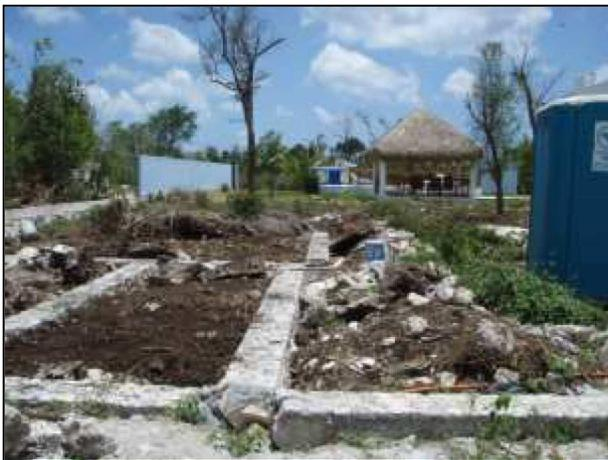
La cimentación para las obras y edificios se resolverá a base de zapatas corridas y zapatas aisladas de concreto armado, desplantadas sobre roca firme con rellenos compactados al 95% con material de banco libre de materia orgánica.
