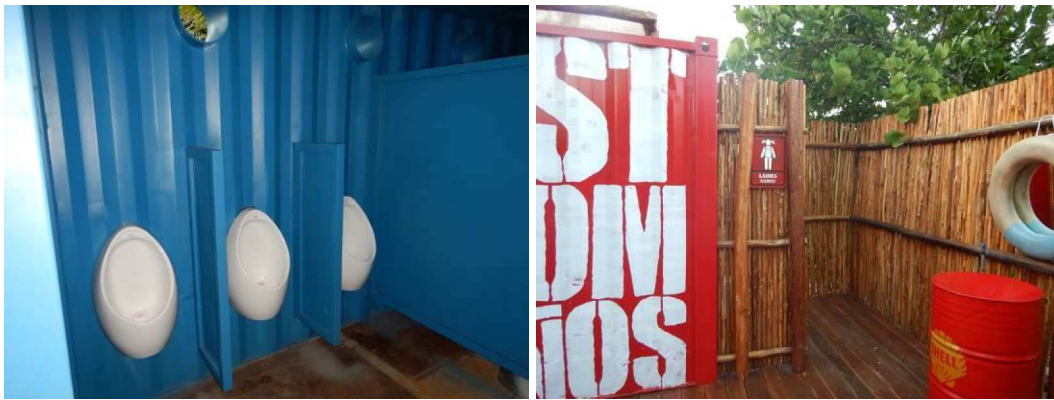
Imagen 9. Instalación de servicios sanitarios
