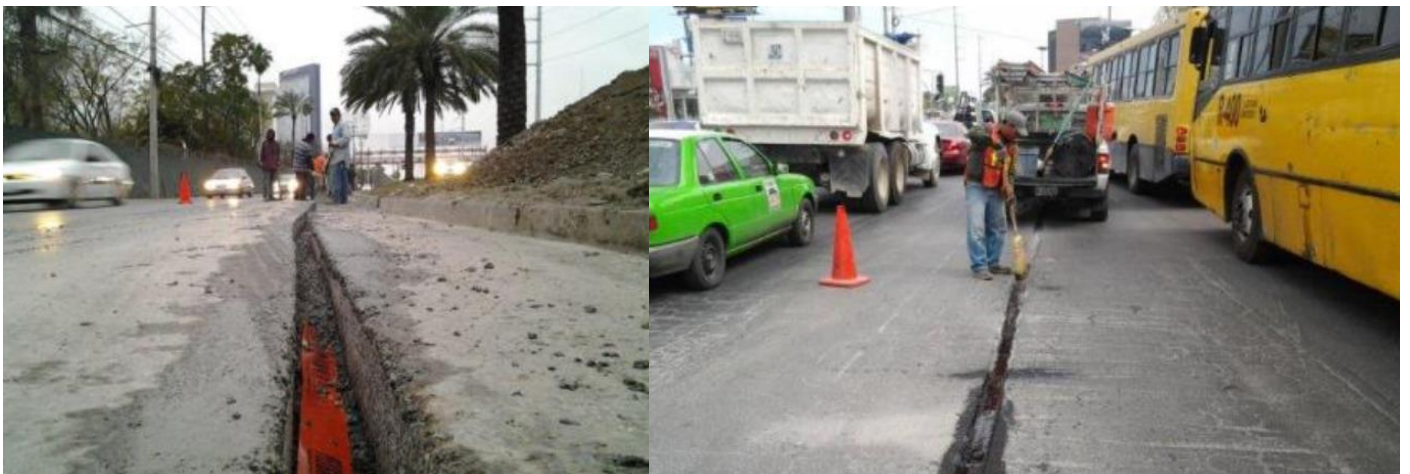
FIGURA 14 EJEMPLO DEL PROCESO DE COLOCACIÓN DE CINTA DE ADVERTENCIA Y CIERRE DE CEPA.
