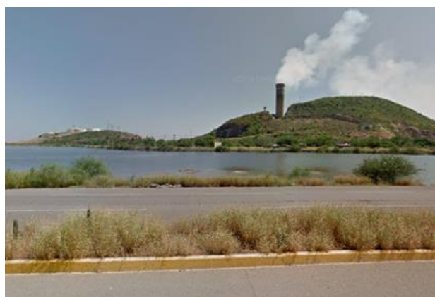
Hidroeléctrica de CFE en Topolobampo, Sinaloa.
