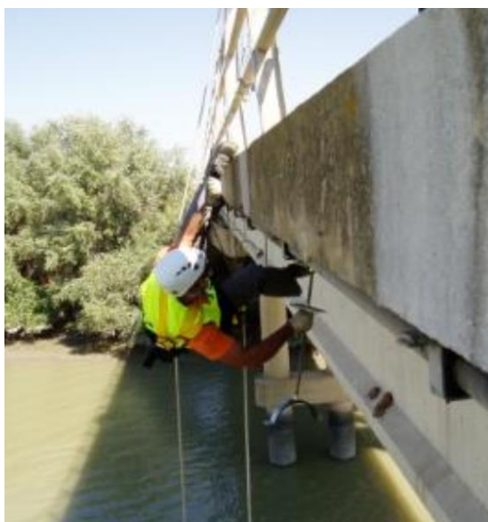
FIGURA 18 PERFORACIÓN PARA COLOCACIÓN DE TAQUETES PARA ADOSAMIENTO A PUENTE. Fuente: Elaboración propia.
