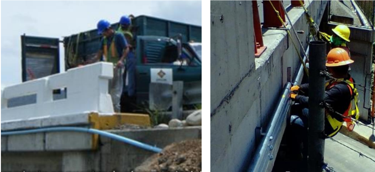
FIGURA 19 PROCEDIMIENTO DE ADOSAMIENTO A PUENTE.
