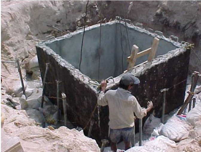
FIGURA 16 EJEMPLO DE CONSTRUCCIÓN DE UN REGISTRO EN PLAYA (BEACH MANHOLE O BMH)
