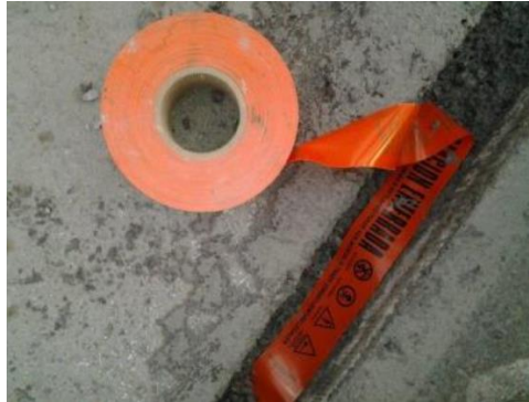
FIGURA 13 COLOCACIÓN DE CINTA DE ADVERTENCIA.
