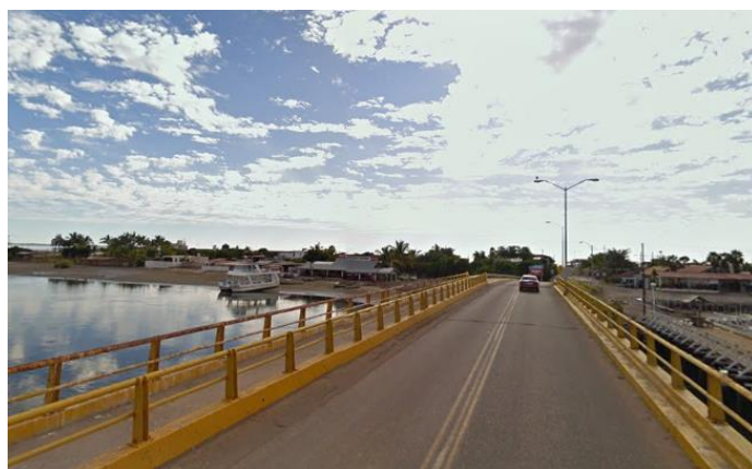
Puente en el que se llevará a cabo el adosamiento, a la entrada a El Maviri.
