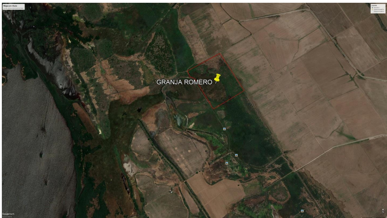
Predio ubicado dentro del límite con Coordenadas Aproximadas de Delimitación
