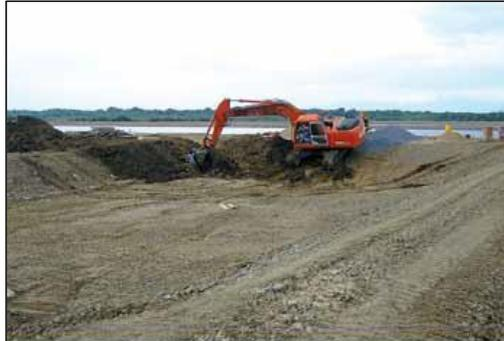
Imagen No. 29. Esta imagen ejemplifica la formación de bordos perimetrales usando el mismo material producto de la nivelación (despalme).
