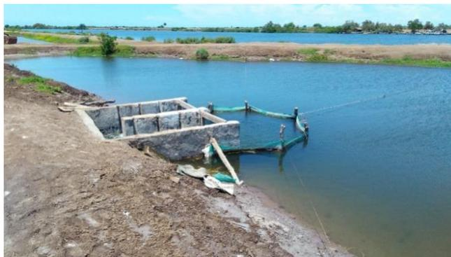
**Fotografías 4 y 5.** Compuertas de entrada de agua.
