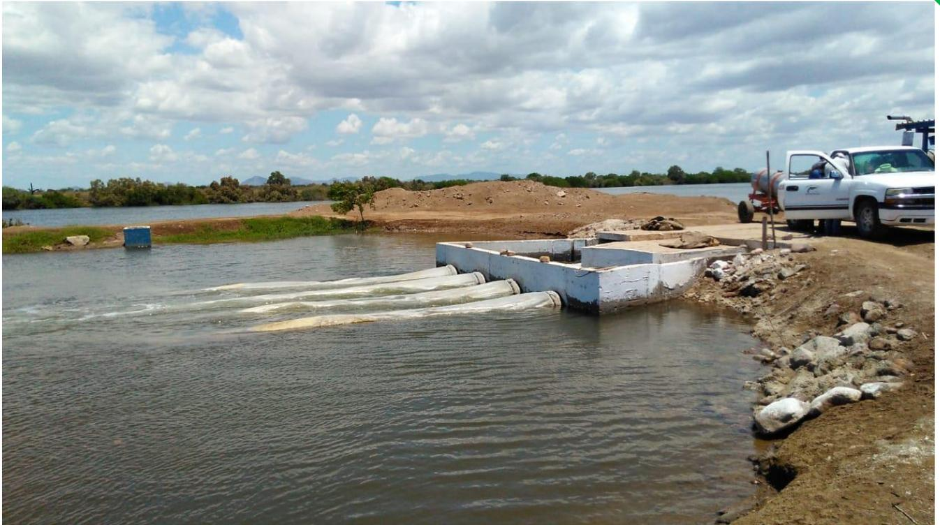
**Fotografía 15.** Dispositivo de filtrado (mallas)
