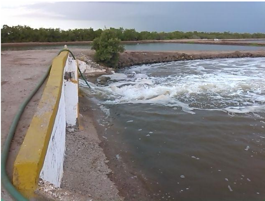
Proceso de llenado del reservorio por medio del canal de llamada, después del cárcamo de bombeo.
