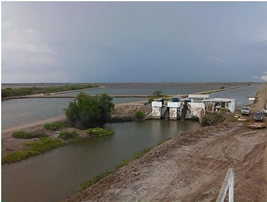
Aspecto del polígono de la granja. Se aprecia el canal de llamada y el cárcamo de bombeo.
