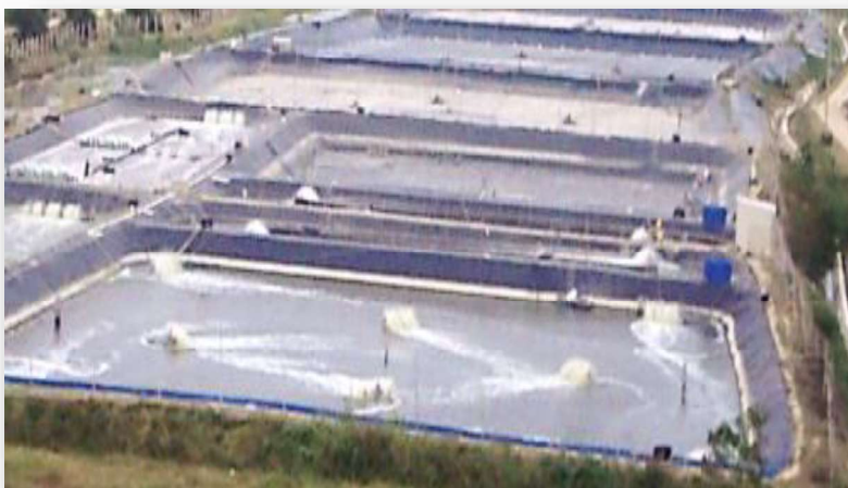
ESTANQUES PROTOTIPO PARA LA FASE 2 DE ENGORDA
