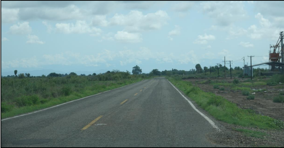
Carretera pavimentada tipo C sin acotamientos hasta la entrada a la granja.
