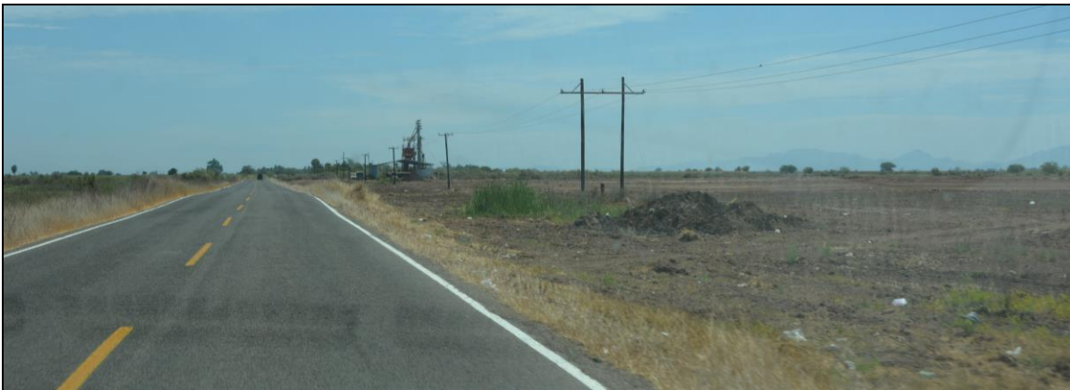
Carretera pavimentada Angostura-Playa Colorada.
