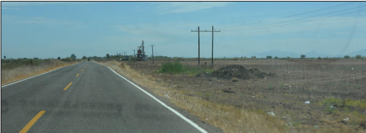
Carretera pavimentada Angostura-Playa Colorada.
