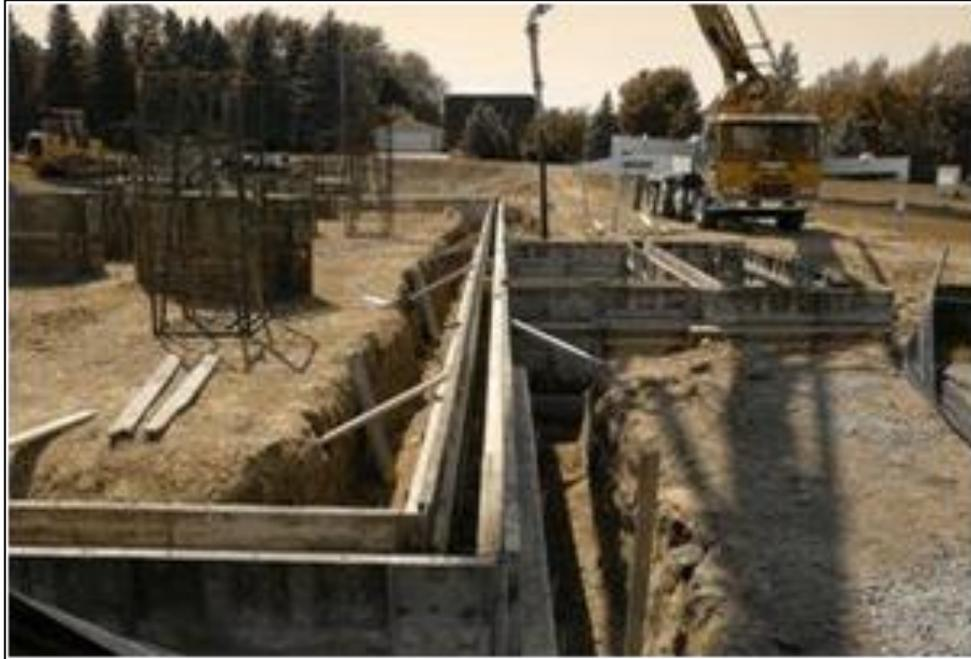
**Figura II.13.-** Cimentación superficial del tipo de las zapatas corridas. Foto ilustrativa.
