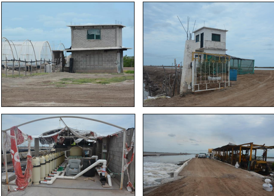
Figura II.6. Obras auxiliares de la granja ACUASHIRMP SPR. DE RI.
