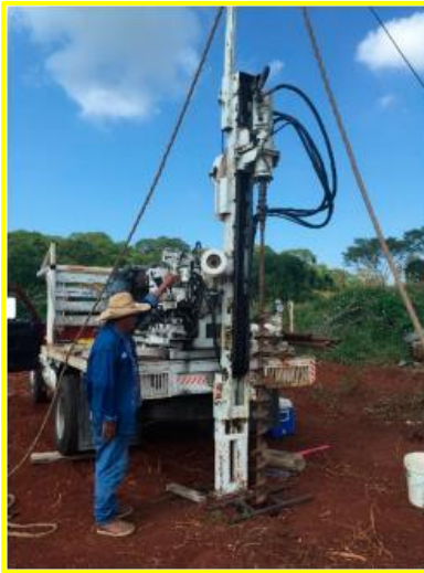
FOTOGRAFÍA Avance con Auger sólido en SPT-1. Esta herramienta pudo utilizarse en todos los sondeos sin que se presentaran problemas de caídos.
