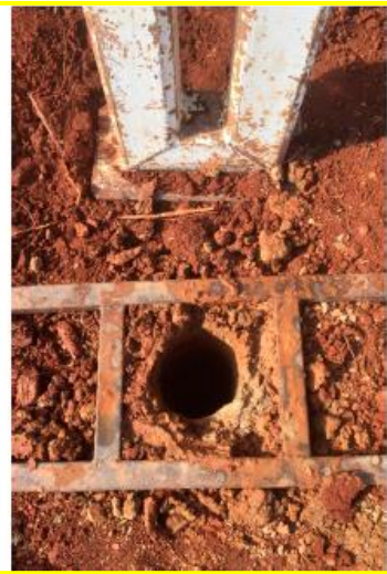
FOTOGRAFÍA Detalle de la perforación realizada con el Auger hasta alcanzar la profundidad de realización de un ensayo SPT
