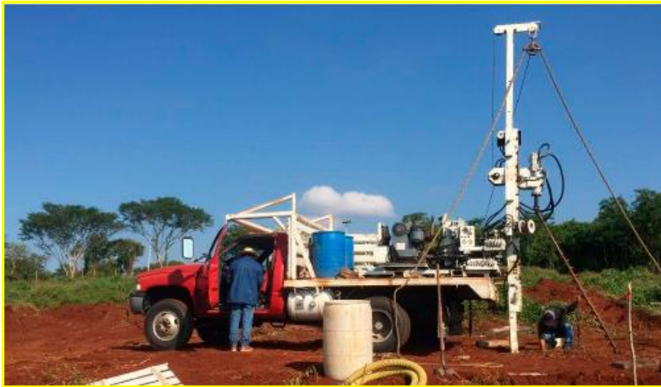
FIGURA II.10. Equipo empleado para la realización de la exploración, ubicado en el sitio de sondeo SPT-1
