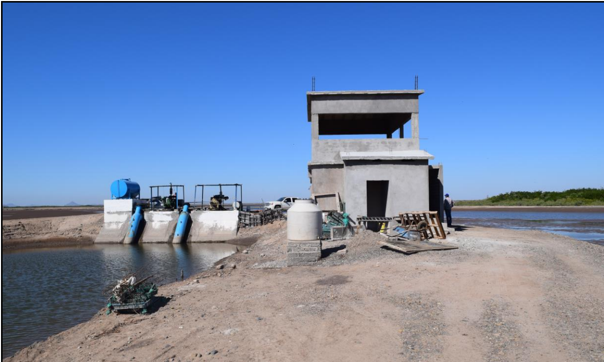
Cárcamo de bombeo y edificio de usos múltiples.
