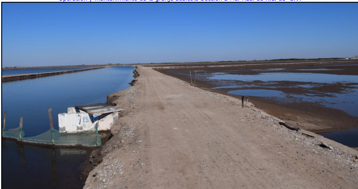
Bordos de la granja acuícola. Estanque No. 7.
