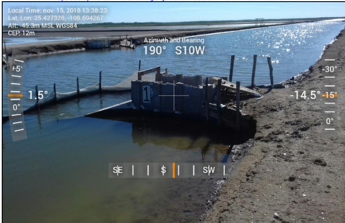
Canal de llamada y compuerta entrada estanque No.1 .Al fondo estanques No. 8 y No.9.
