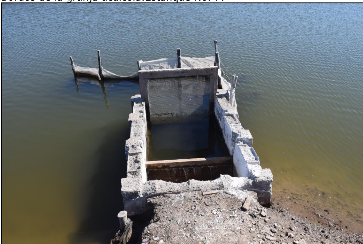
Tipo de estructura de control para la entrada de agua a estanques.
