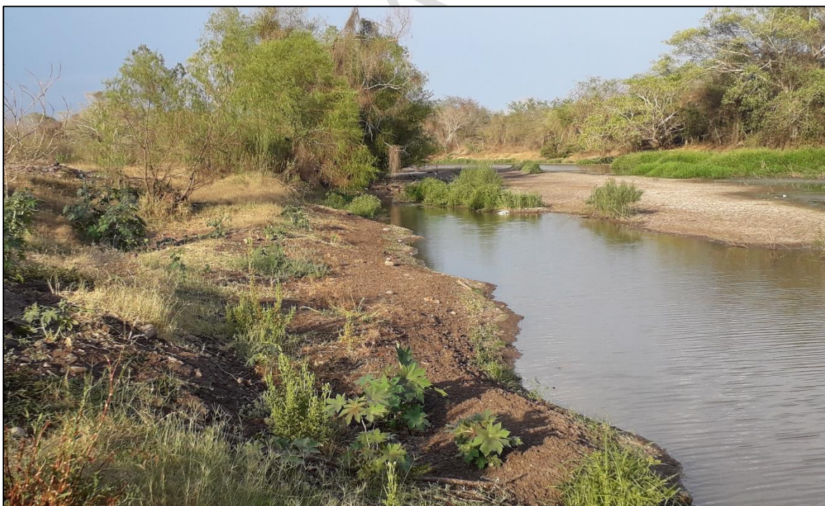
Fotografía No. 1.- Panorámica del cauce en la zona del proyecto.
