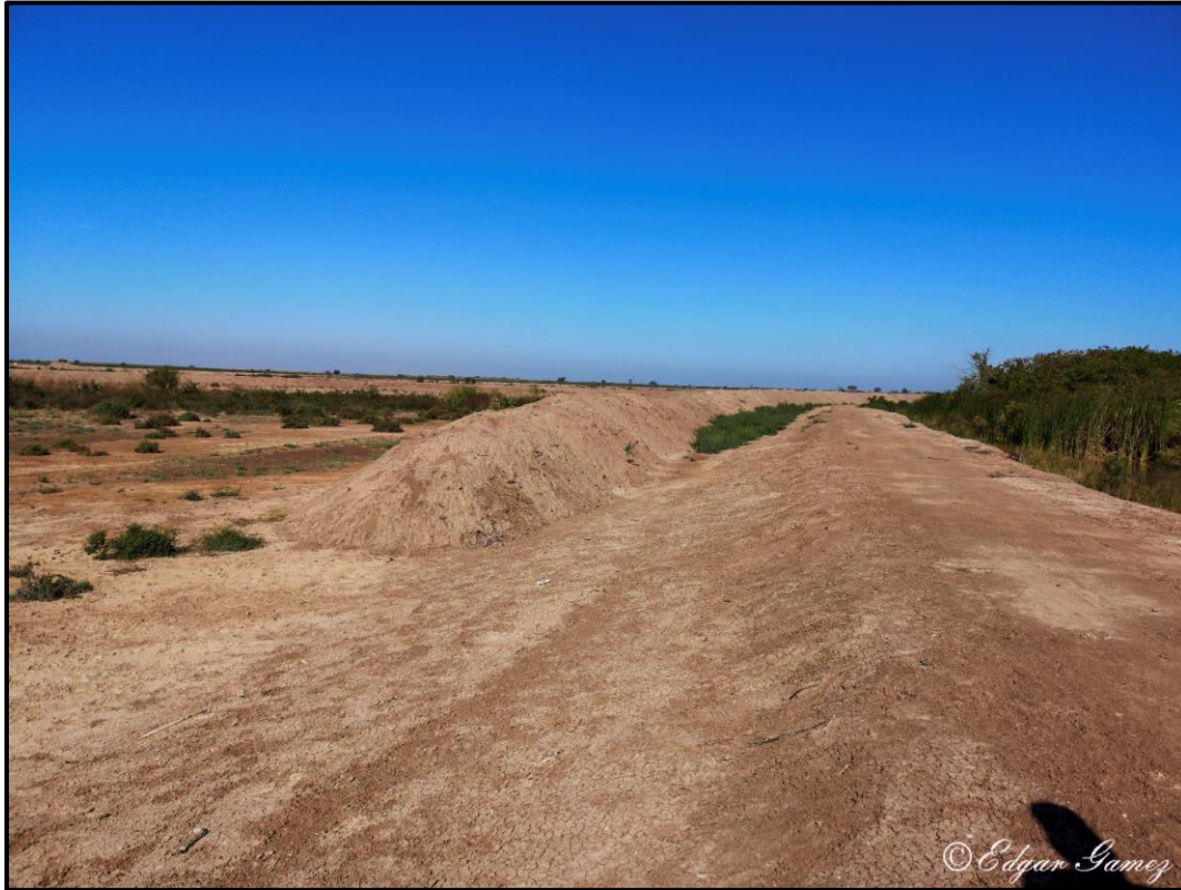
Figura 10.- Vista de la bordería perimetral objeto del proceso administrativo con PROFEPA.
