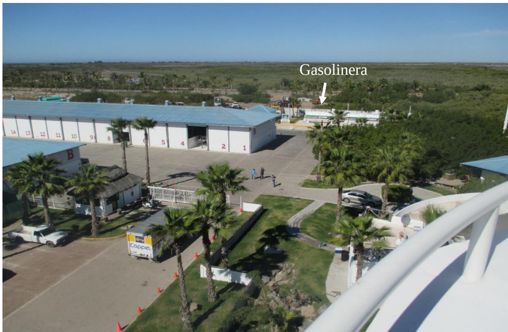
Foto donde se muestra la ubicación de la Gasolinera con respecto a las instalaciones del Embarcadero.
