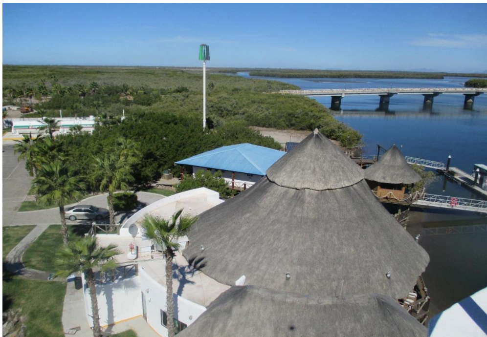
Foto donde se observa la palapa del restaurant, gasolinera, almacén y andadores que conectan con el peine del Embarcadero.
