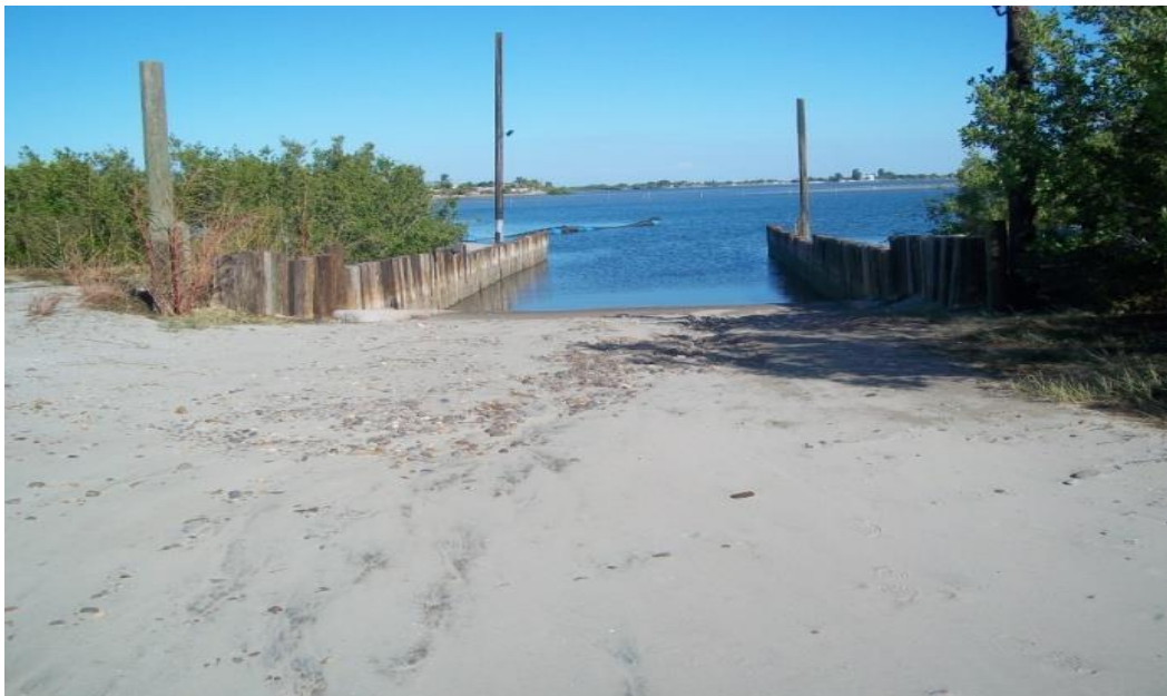
Rampa que forma parte de las instalaciones del Embarcadero.
