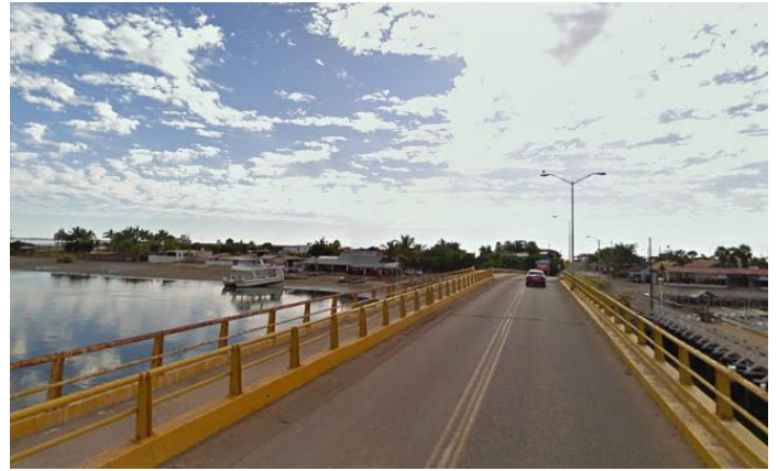
Puente en el que se llevará a cabo el adosamiento, a la entrada a El Maviri.
