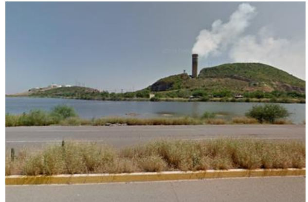
Hidroeléctrica de CFE en Topolobampo, Sinaloa.
