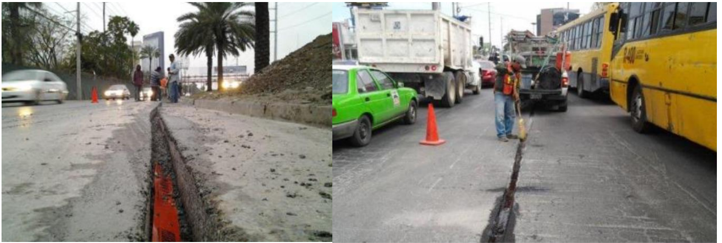
FIGURA 15 EJEMPLO DEL PROCESO DE COLOCACIÓN DE CINTA DE ADVERTENCIA Y CIERRE DE CEPA.
