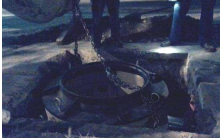
FIGURA 16 EJEMPLO DE INSTALACIÓN DE REGISTRO.
