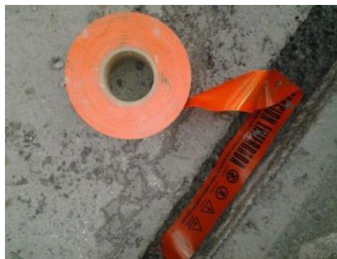
FIGURA 14 COLOCACIÓN DE CINTA DE ADVERTENCIA.
