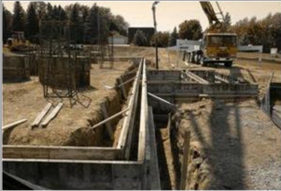
**Figura II.31.-** Cimentación superficial del tipo de las zapatas corridas. Foto ilustrativa.
