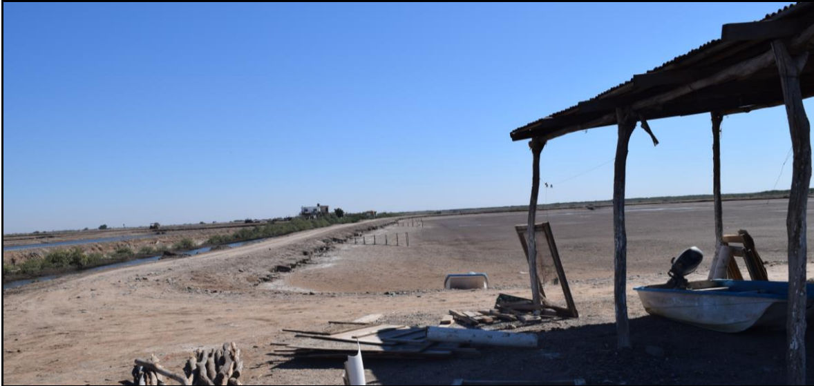
Reservorio y uno de los estanques.
