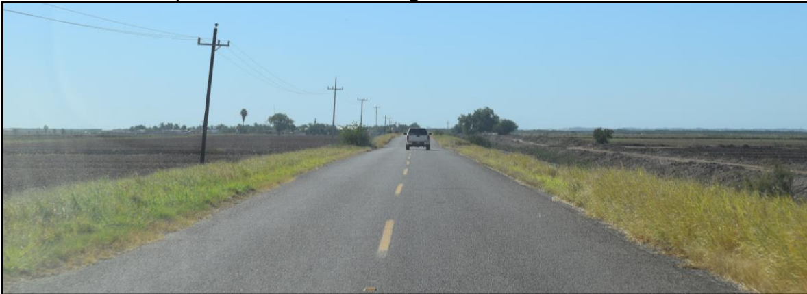
Carretera pavimentada Tipo C que conduce a la población de El Tortugo.
