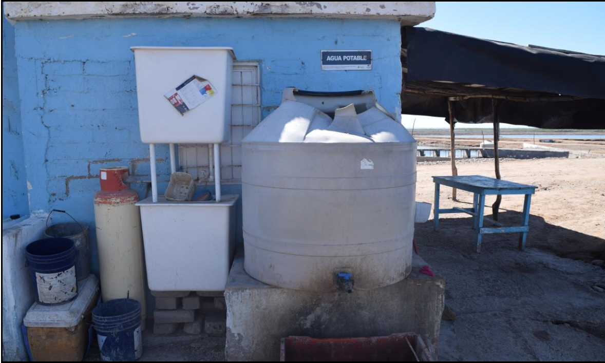
Deposito para agua potable.
