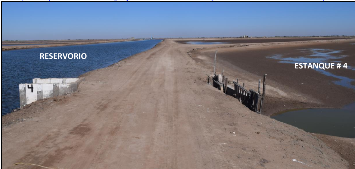
Detalle de los bordos de los estanques de la granja acuícola.
