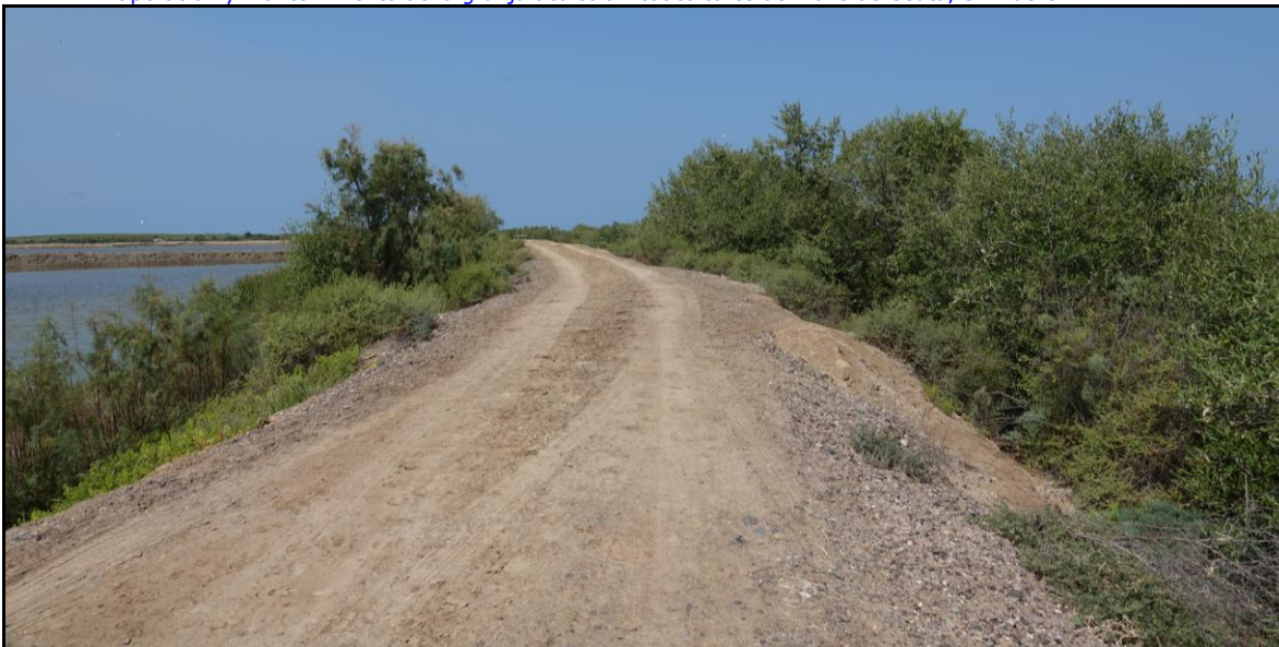
Vegetación en los taludes internos y externos de la bordería.
