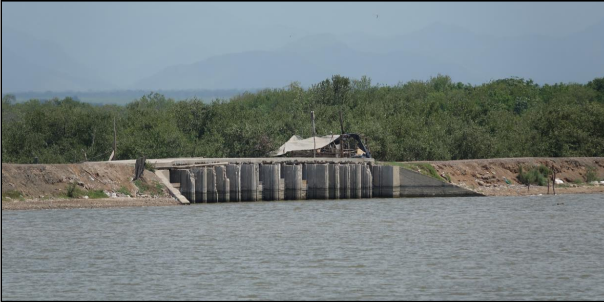
Estructura de control para drenado estanque #3.
