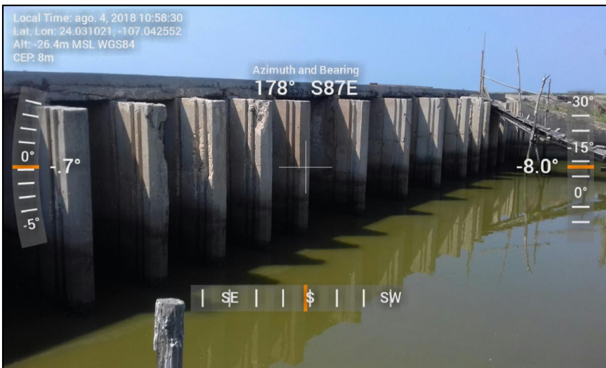
Puente sobre compuertas.
