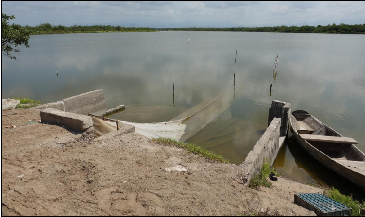
Malla filtradora (excluidora de fauna acuática). Estanque No.1.
