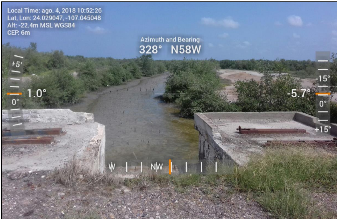
Antiguo cárcamo de bombeo, hoy en desuso.
