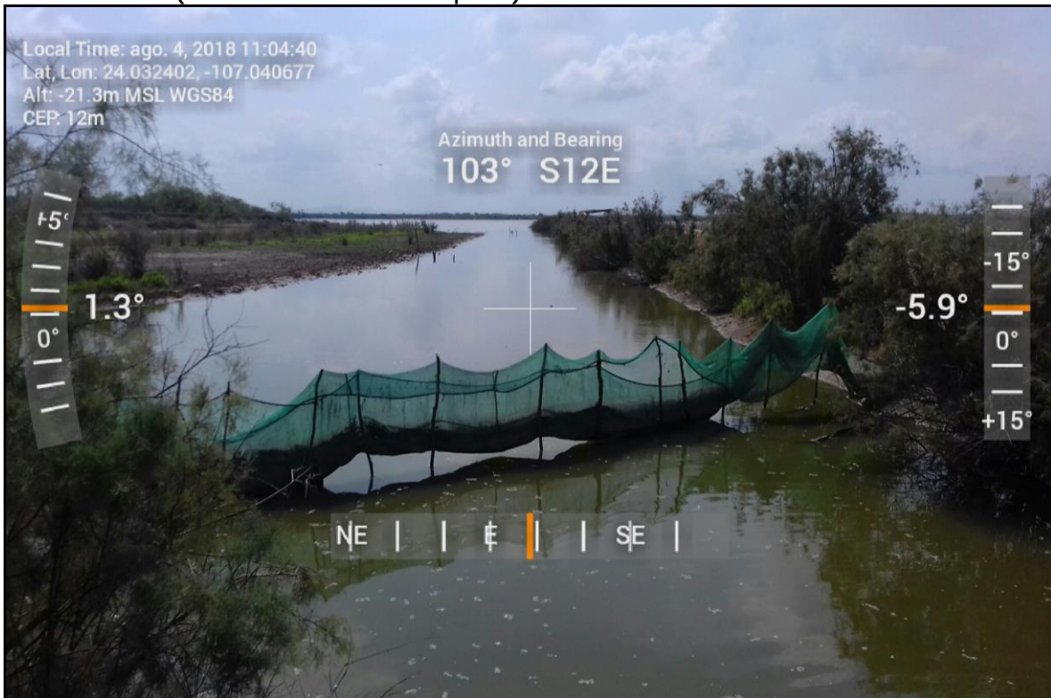
Canal de llamada y malla filtradora.
