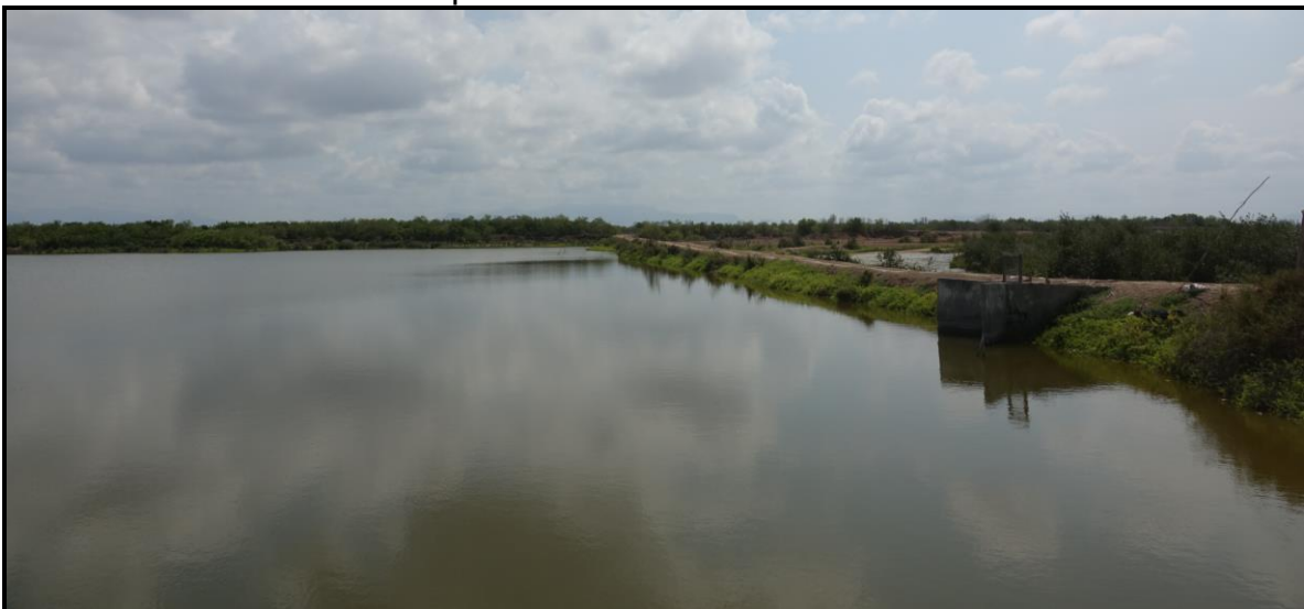
Estanquería de la granja acuícola. Estanque No. 1.
