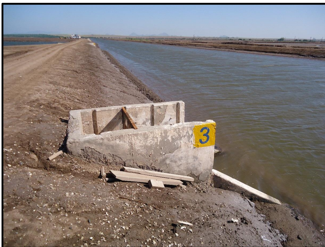
Figura IV. 13 En esta fotografía puede observarse el predio sin vegetación
