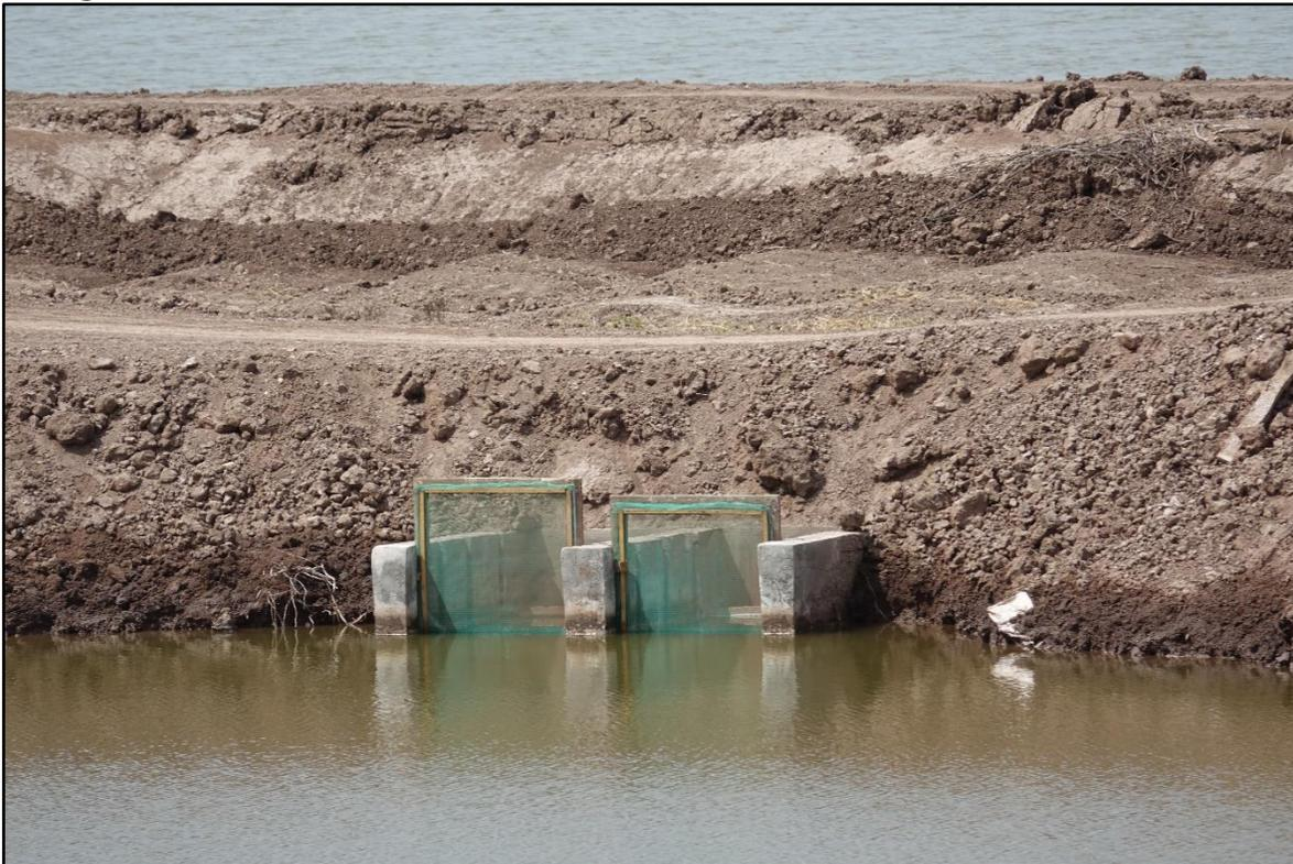
En los estanques se cuenta con mallas de seguridad, el cual es un dispositivo de red fina montada sobre un bastidor de madera.
