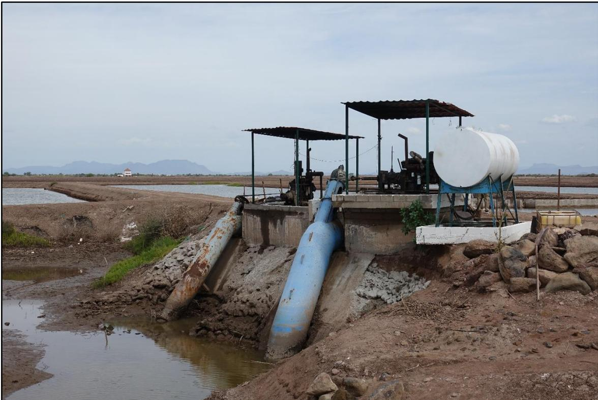
Cárcamo de bombeo y tanque de diésel con dique de protección.
