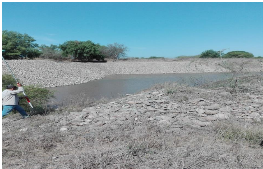
No.10. Laguna dentro de polígono, el agua se utiliza para lavar el material pétreo de la criba y regresa de nuevo a la laguna.
