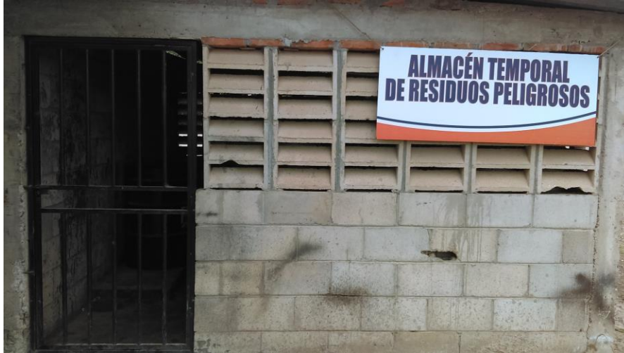
Imagen 16. Vista de almacén temporal de residuos peligrosos.
