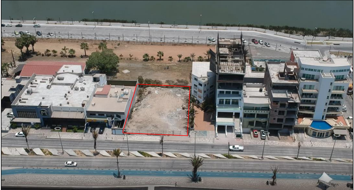
Fotografía II.1. Condición actual del predio donde se desarrollará el proyecto (norte).
