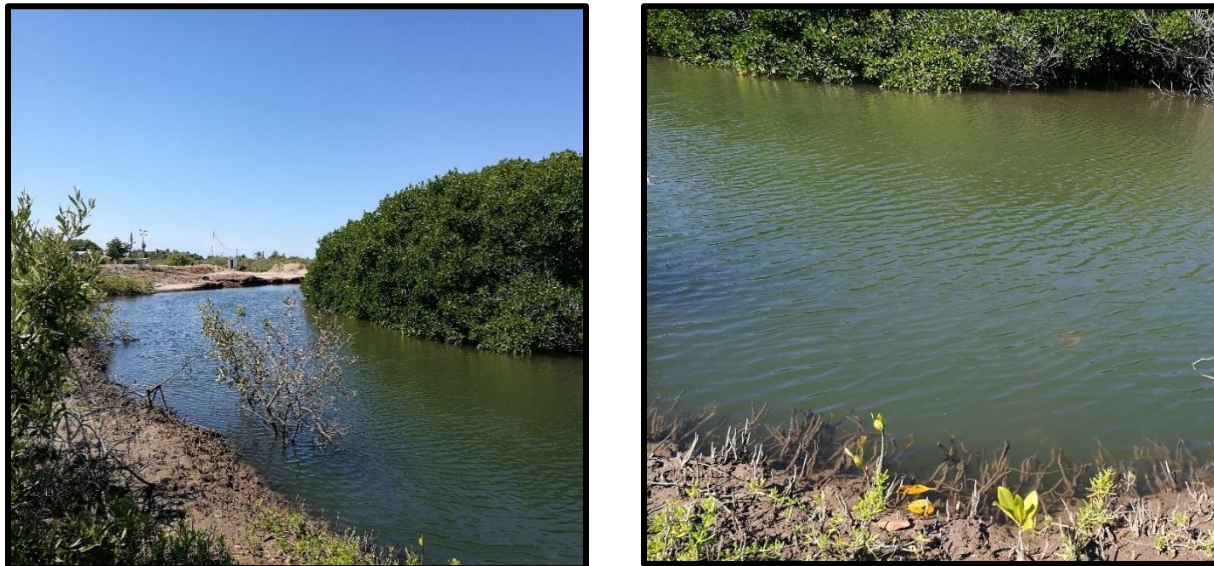
Figura II.7. Canal de llamada construido y en operación por la granja vecina
