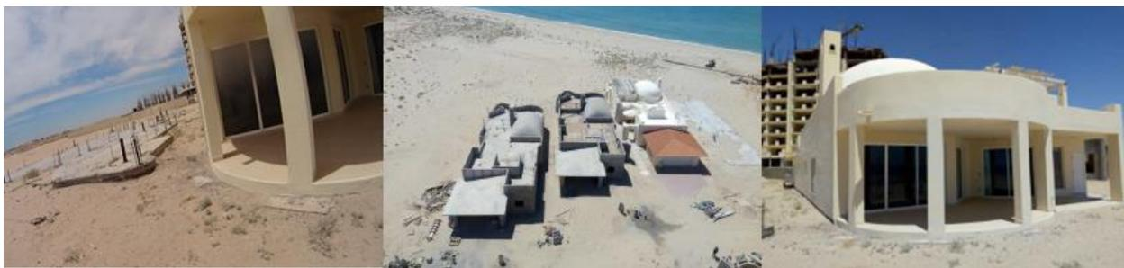
La cimentación es a base zapata corrida de concreto armado de 0.60 m x 20 cm y contratrase de 20 cm de espesor, la estructura de elementos de concreto armado y castillos de 20 x 20 cm, cerramientos de 20 x 20 cm, traveses y columnas de diferentes secciones, techumbre de madera de pino, losa llena de concreto armado y de tabique para construcción de cúpulas descansando sobre muro de carga.
