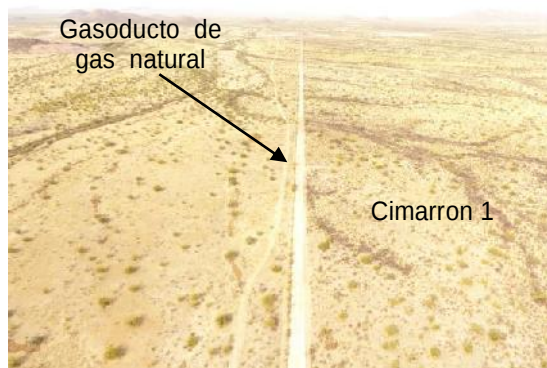
Gasoducto de gas natural, delimitando por el lado norte al sitio del proyecto
