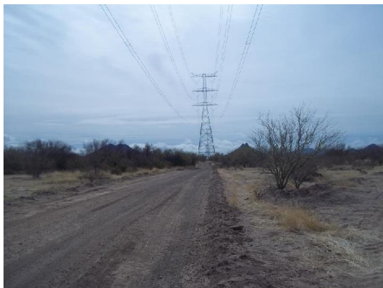
Torres de línea de transmisión eléctrica
