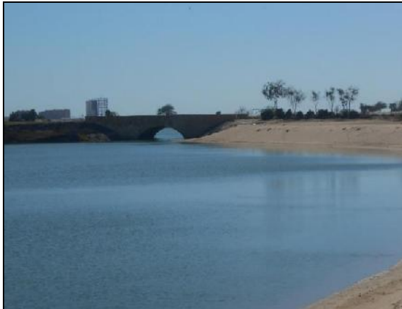
Fotografía II. 41 Configuración de taludes
