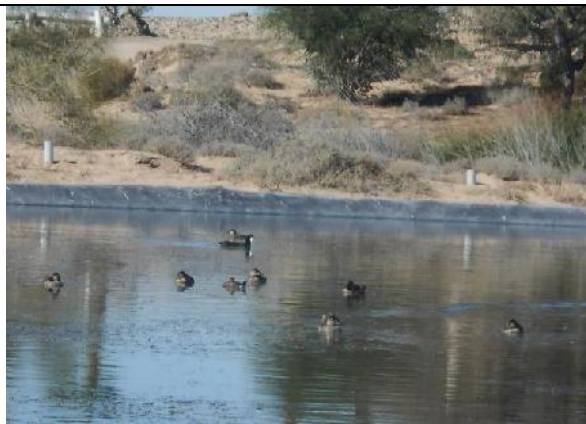
Fotografía II. 17 Lago de riego con geomembrana
