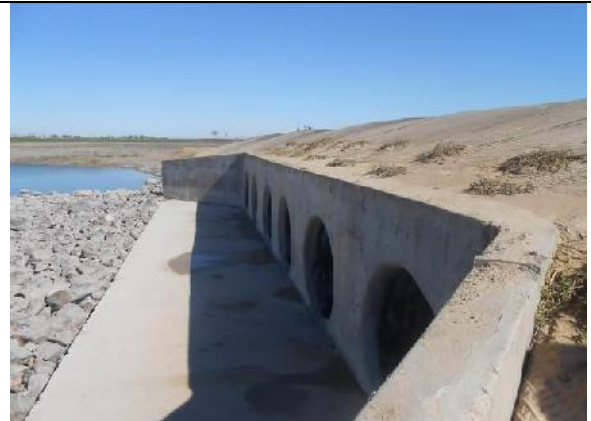
Fotografía II. 20 Estructura de control de niveles de agua
