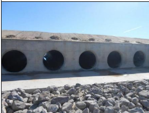
Fotografía II. 43 Estructura de control de niveles.
