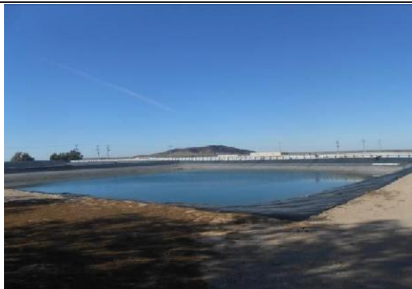
Fotografía II. 12 Estanques de almacenamiento de agua
