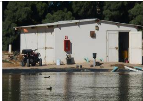
Fotografía II. 18 Estación de bombeo
