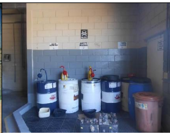
Fotografía II. 51 Edificio de mantenimiento
