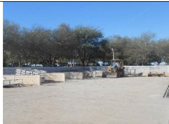
Fotografía II. 16 Almacenamiento de materiales
