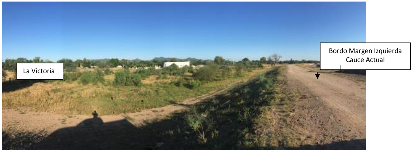
Figura II.13.- A la Izquierda, terrenos que sufren inundaciones constantes en “La Victoria” más bajos que nivel de bordo. A la derecha bordo de la margen izquierda del Río San Miguel
