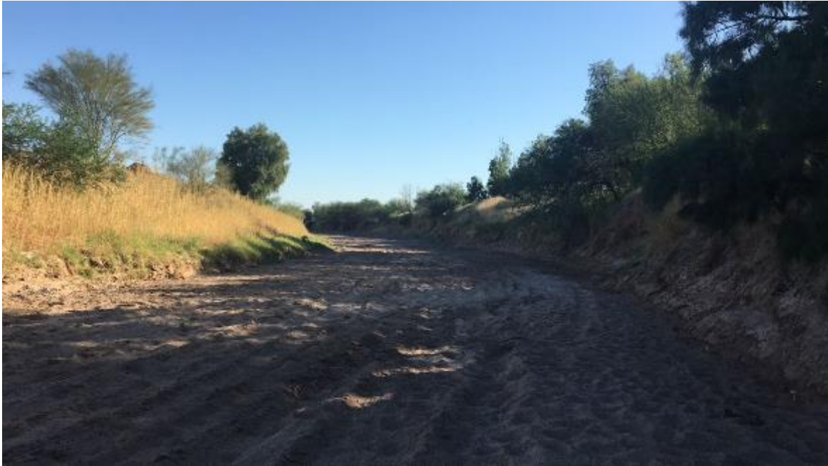
Figura II.5.- Cauce Actual Río San Miguel. Plantilla de 15 m. Capacidad de Conducción de 251.37 m 3 /s. Sept 2018
