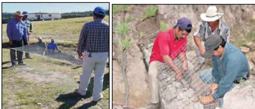
Figura IV.21 Doblaje de malla y colocación en zanja
