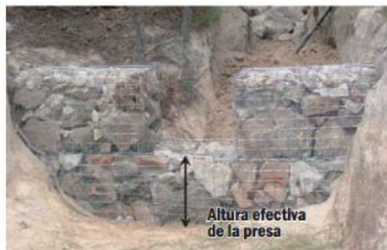
Figura IV.16 Altura de la presa
