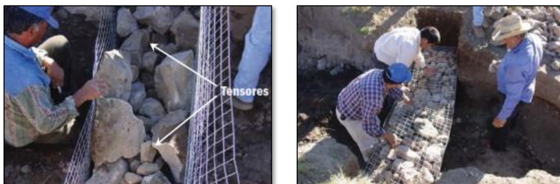
Figura IV.22 Colocación de tensores y llenado de cajón
