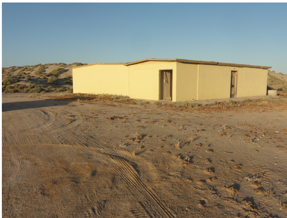
Vista Sureste de Bodega Provisional propuesta para Mantenimiento y Jardinería
