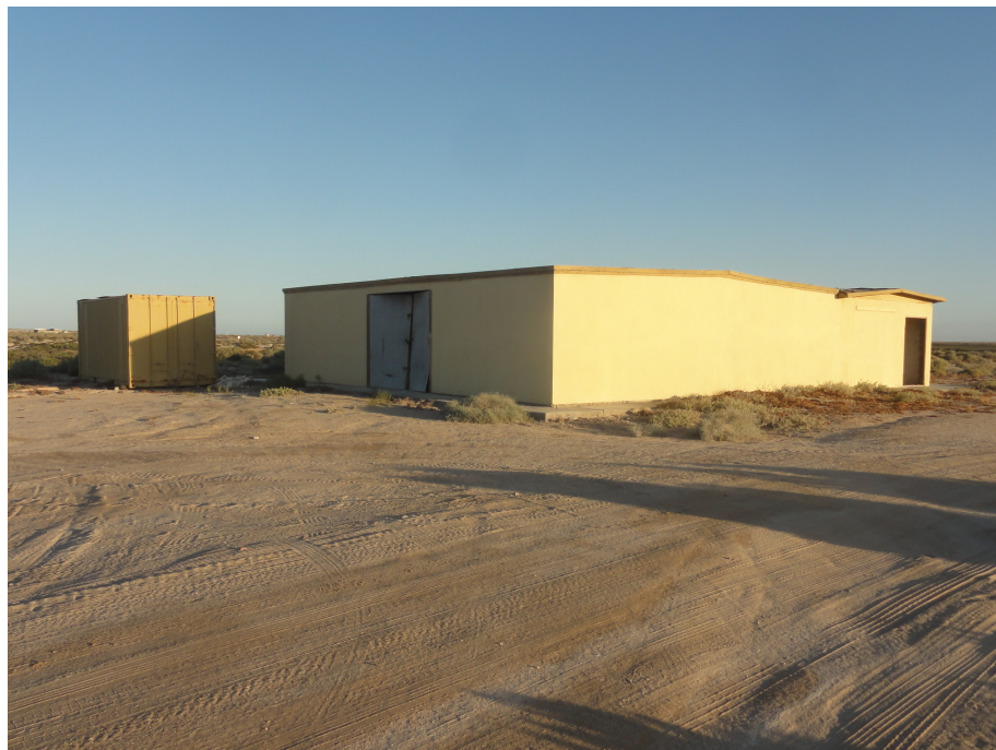
Vista Noroeste de uso actual como Bodega Provisional
