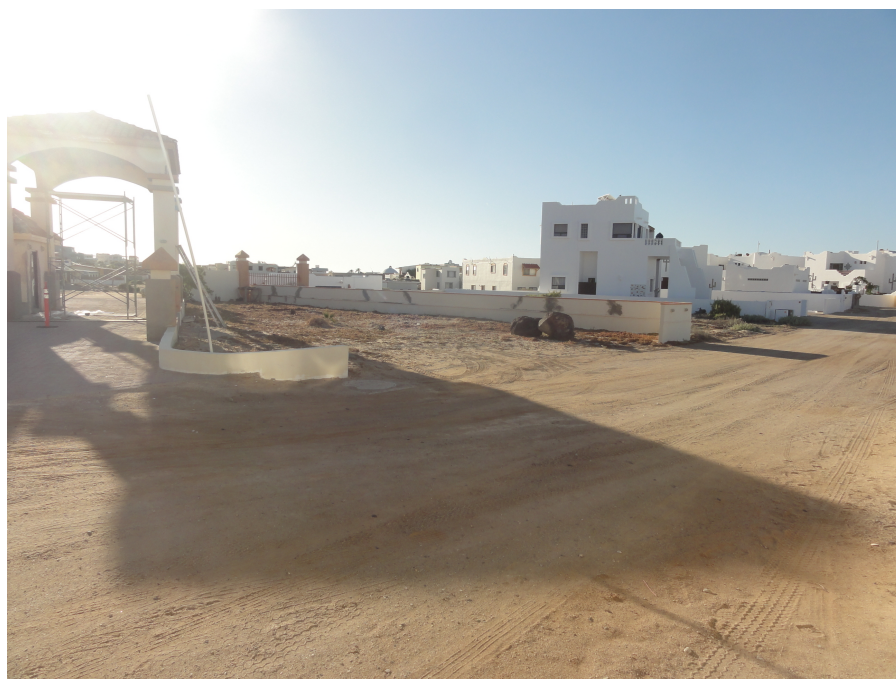
Vista poniente del Lote 1, sobre la Calle Calamares
