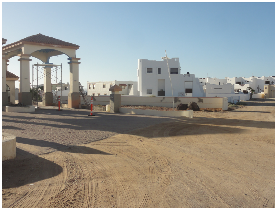
Vista del vértice Noreste del Lote 1, sobre la Calle Calamares y Avenida La Jolla
