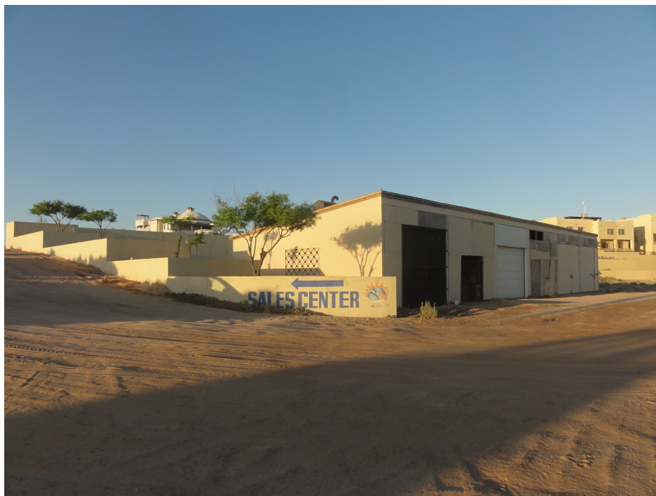
Vista del vértice Noreste de los Lotes 1-A, 1-B y 10-A sobre la Calle Abulones Actualmente utilizada como Bodega provisional de obra.
