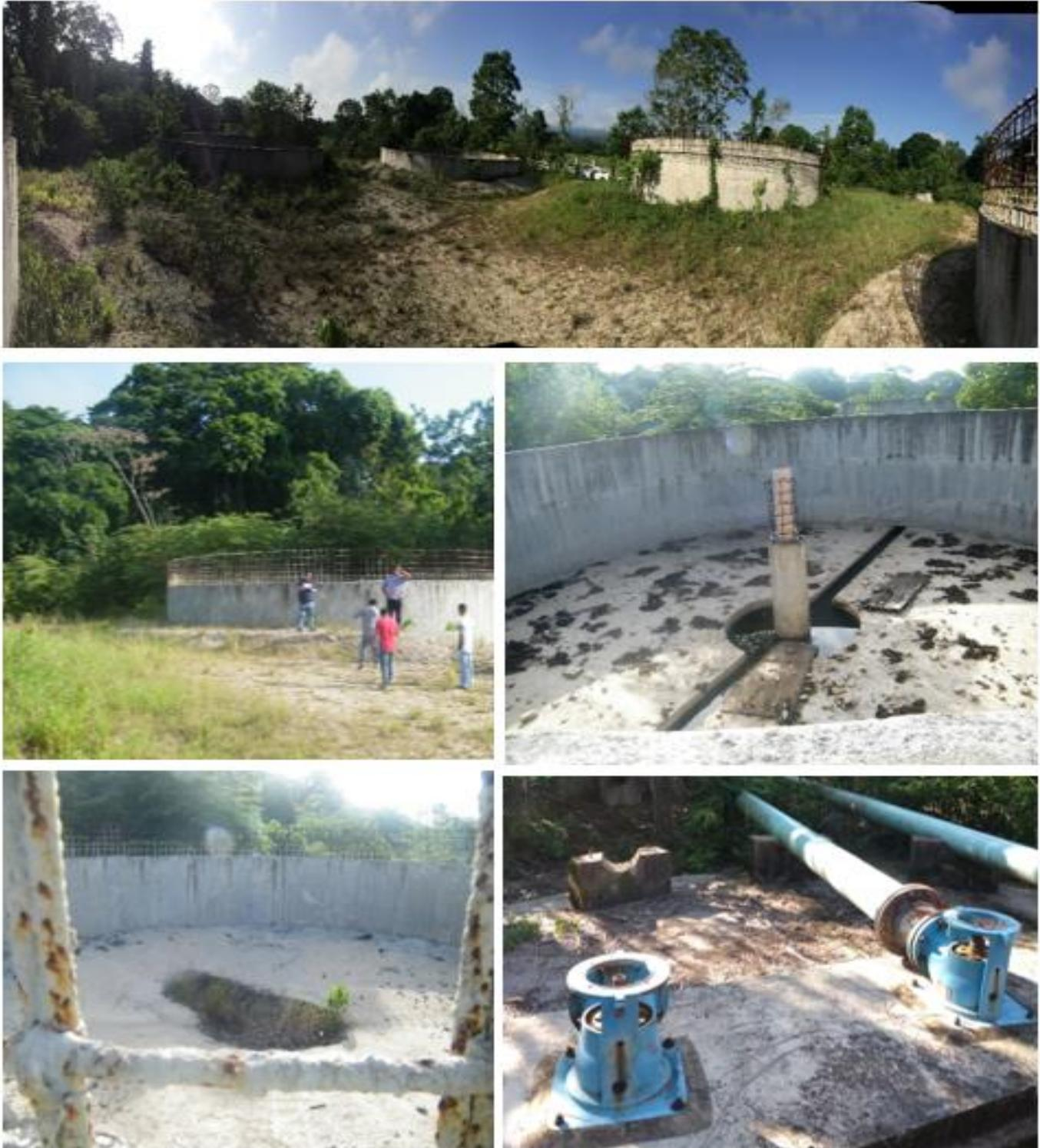
**Ilustración VII.1 Vista de las condiciones actuales de las estructuras existentes de la PTAR, Palenque Chiapas.**
