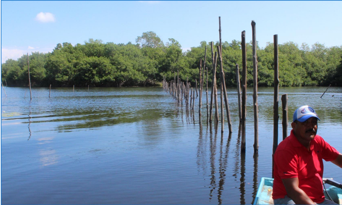
IMAGEN 4. - TAPO RÚSTICO DETERIORADO, LAGUNA CHANTUTO.
