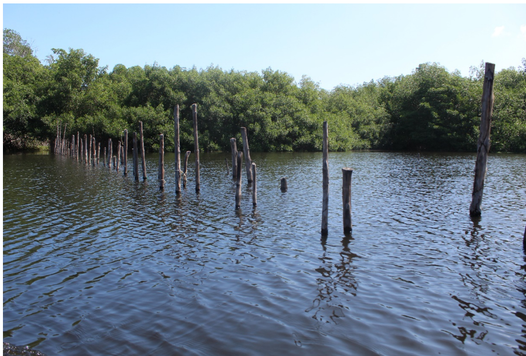
Imagen 8. En las imágenes se pueden ver los postes que se encuentran en la Laguna, mismas que se ocuparan para la instalación de tapo y con esto ocupar la superficie de la Laguna Pampa Chantuto.
