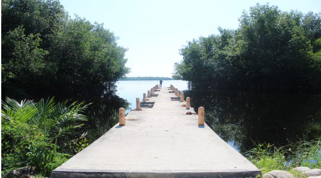
Imagen 15. Como ya se ha mencionado la sociedad cooperativa cuenta con infraestructura (muelle) misma que fue realizado por gobierno municipal y donada a la sociedad, estas se utilizaran para la etapa operativa del proyecto.
