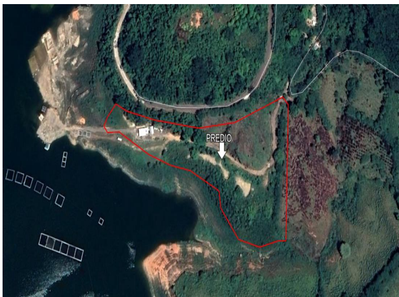
Imagen 17. Vista macro del predio donde se construirán las Instalaciones en Tierra del Proyecto.
