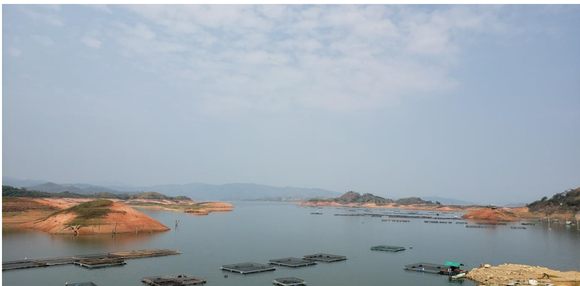
Imagen 2.- Vista de las jaulas flotantes existentes en el embalse de la presa.
