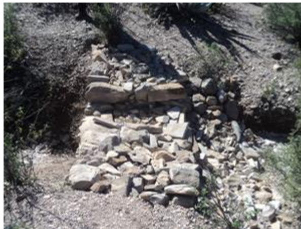
Figura 13. Propuesta para la construcción de Presas filtrantes de piedra acomodada
