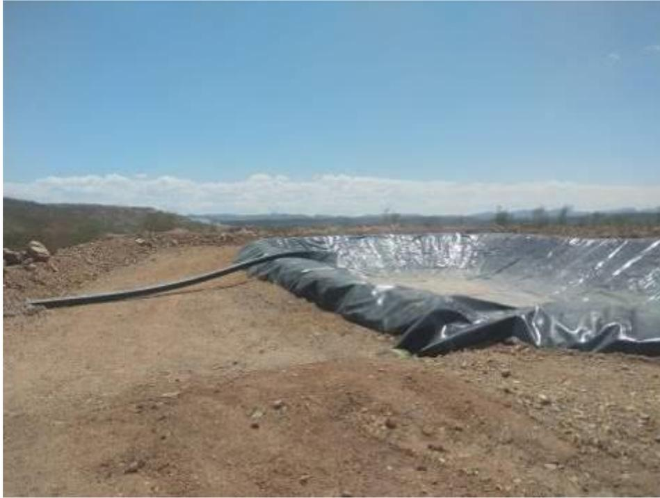
**Fotografía VIII. 6.** Panorama de pileta de salida de línea de conducción de agua
