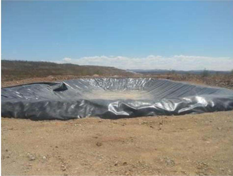
**Fotografía VIII. 2.** Pileta de salida de línea de conducción de agua
