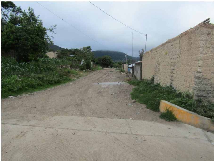
Figura 66. Servicios públicos básicos de La Esperanza (Calle sin pavimentar).
