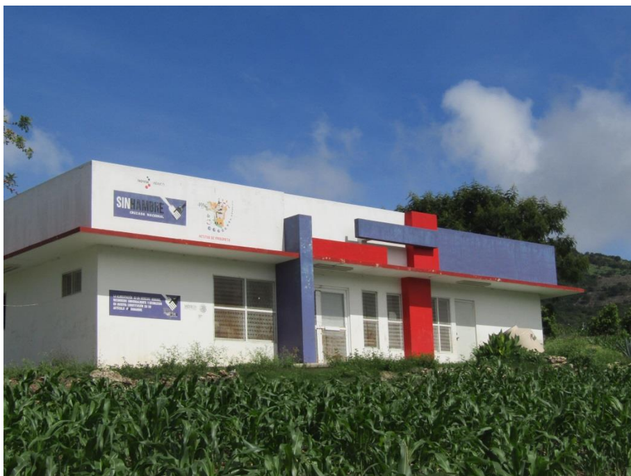
Figura 79. Servicios públicos básicos de La Esperanza (Albergue comunitario y comedor local).
