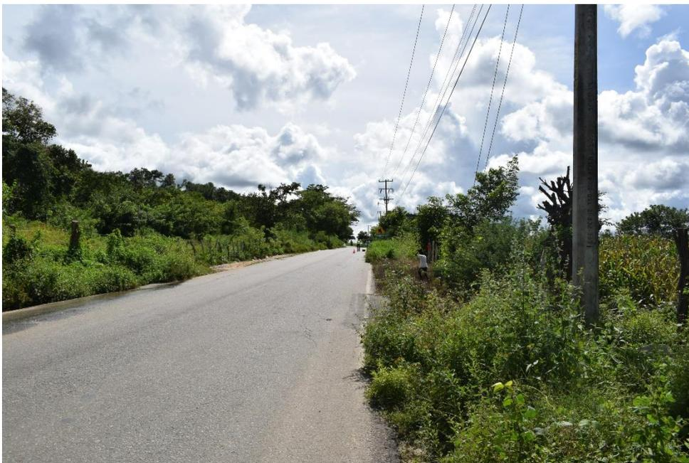
*Fotografía 16. Vista frontal del Km 0+020, en el cual se puede apreciar el ancho de corona de 7 metros de la carretera existente; nótese como en ambos laterales de la carretera no existe vegetación forestal primaria solo dominancia de hierbas y arbustos.*
