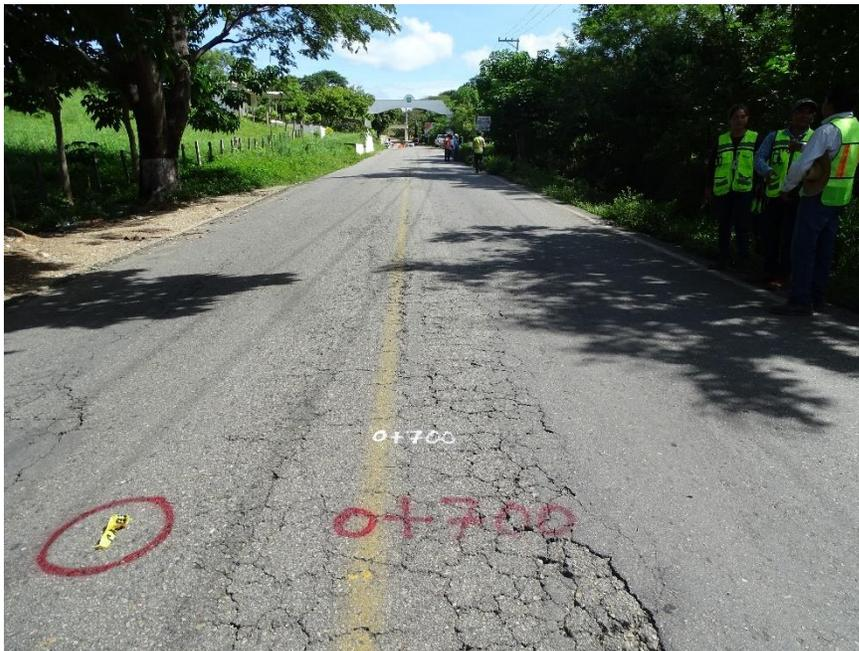
*Fotografía 18. Vista frontal del Km 0+700, en el cual se puede apreciar ancho de corona de superior a los 7 metros con desgaste y disgregación sobre la carpeta asfáltica, nótese los árboles aislados ubicados dentro de los corrales colindantes al área ampliarse para el proyecto.*
